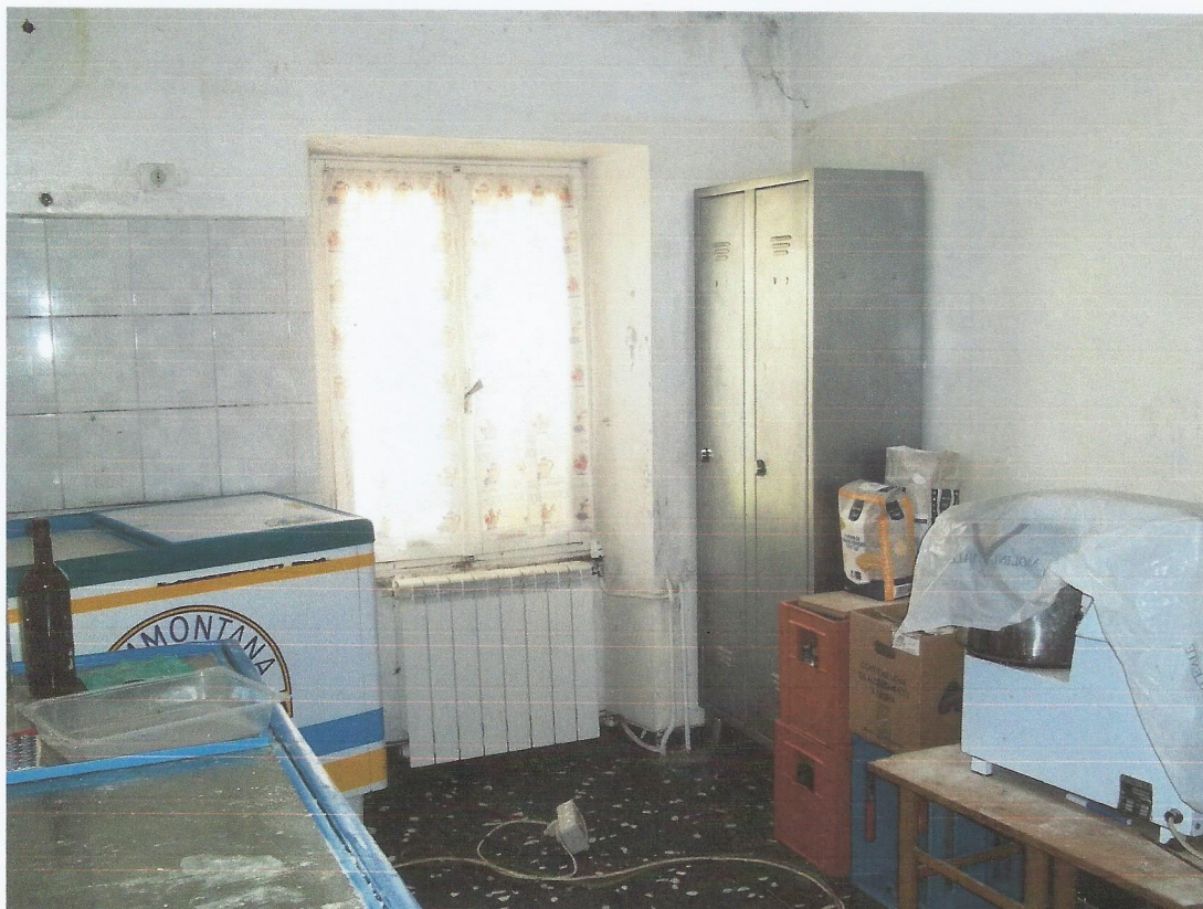
VISTA DEPOSITO SECONDO PIANO
