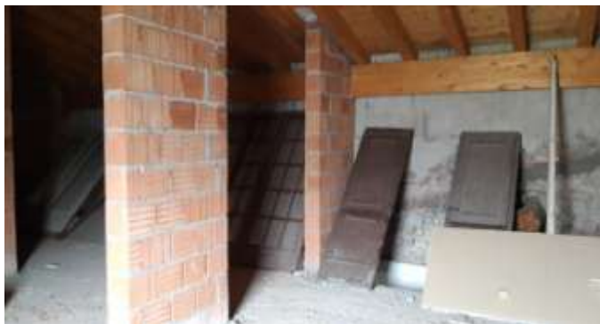
Foto 10: Soffitta garage (a destra)
