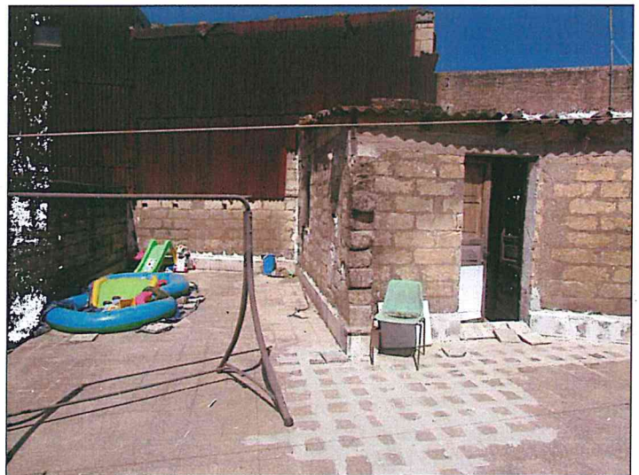
foto 21 - L'ambiente dante sulla terrazza non è rifinito in facciata, è coperto con struttura in legno ed eternit e non si trova in buono stato conservativo.
