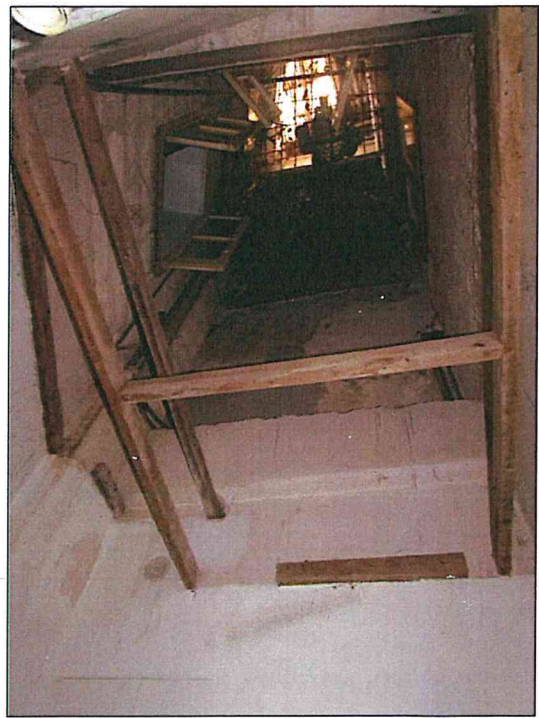
Foto 6-7 - Ambienti wc e cavedio ai quali si accede da un disimpegno. Lo stato conservativo non è buono; in particolare il cavedio non consente una sufficiente illuminazione.
