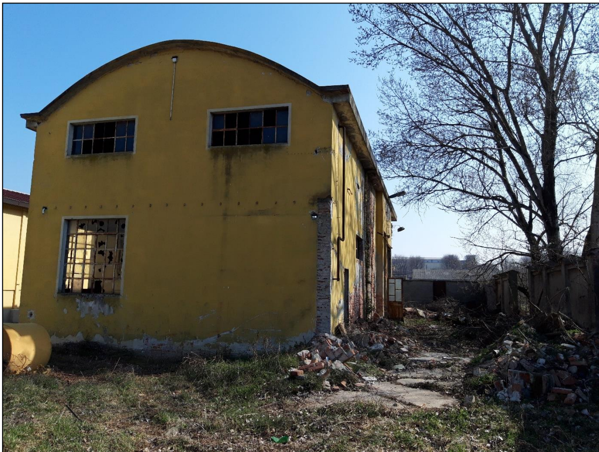
Foto n.23 – altra vista edificio in muratura
