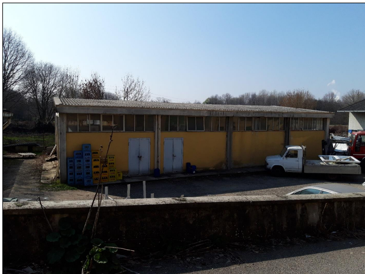
Foto n. 7 e 8 – Capannone in c.a. prefabbricato
