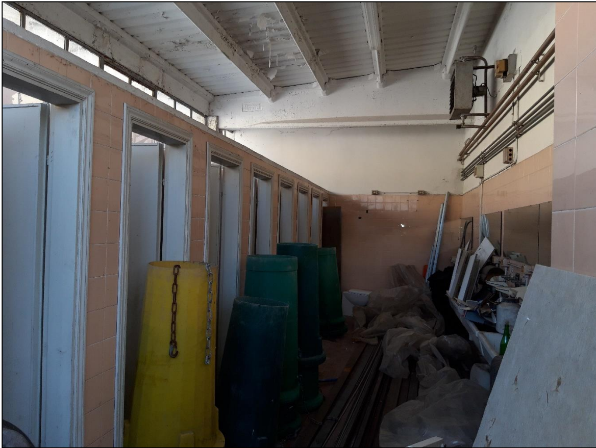
Foto 13 – ex servizi interni al capannone
