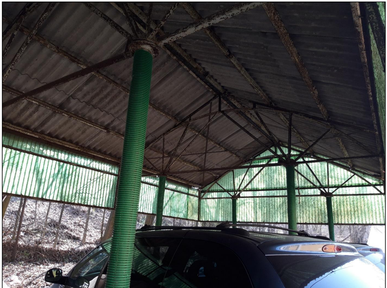
Foto n. 5 e 6 – Tettoia con struttura in ferro
