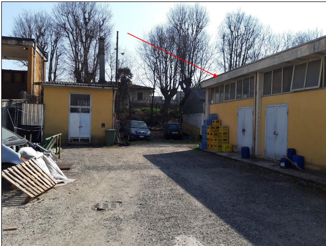
Foto n. 7 e 8 – Capannone in c.a. prefabbricato
