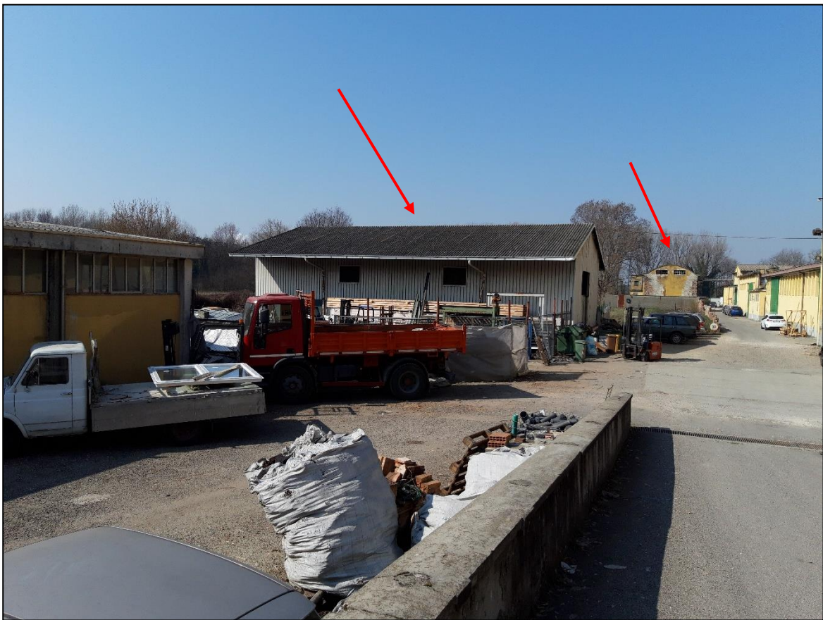
Foto n. 14 – vista altri edifici
