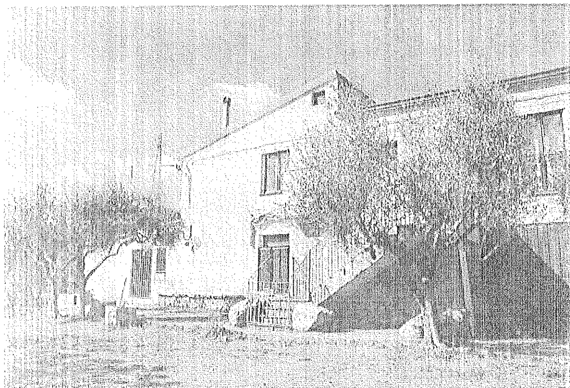
lotto n.100 - Abitazione posta al primo piano a sinistra del fronte principale del fabbricato e allibrata con la P.lla 130 sub 3 Sottostanti alloggio per operai e Deposito 9 posti al piano terra ed allibrati con la P.lla 130 sub 4
