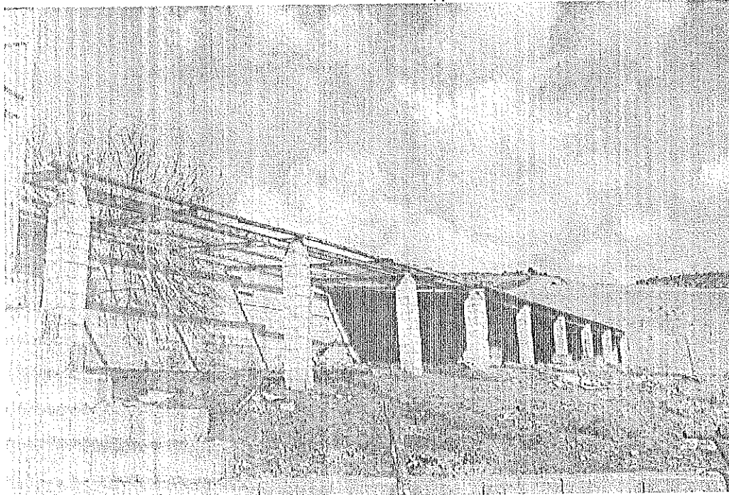
Foto n. 79 -- Ovile Prospetto Sud
