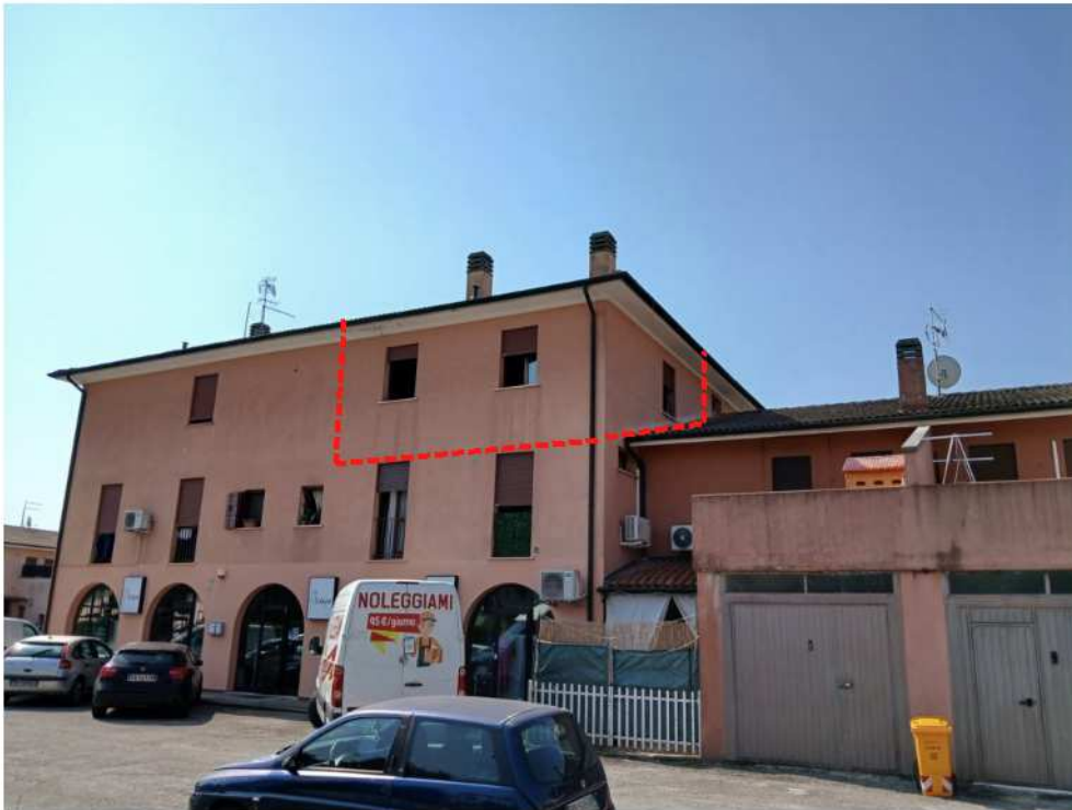
Vista prospetto nord/ovest
