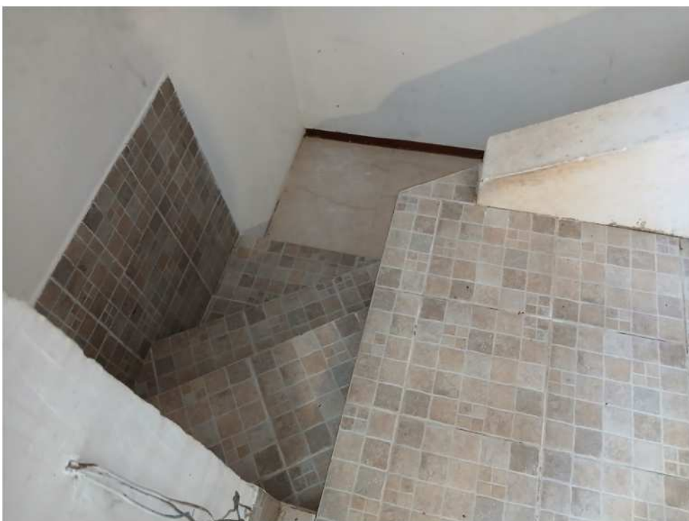
Particolare scala interna – ultimi gradini con altezza diverse tra loro
