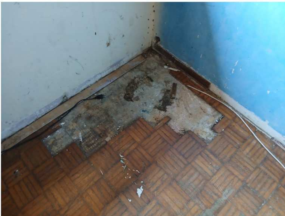
Camera n.2 - particolare pavimento in legno
