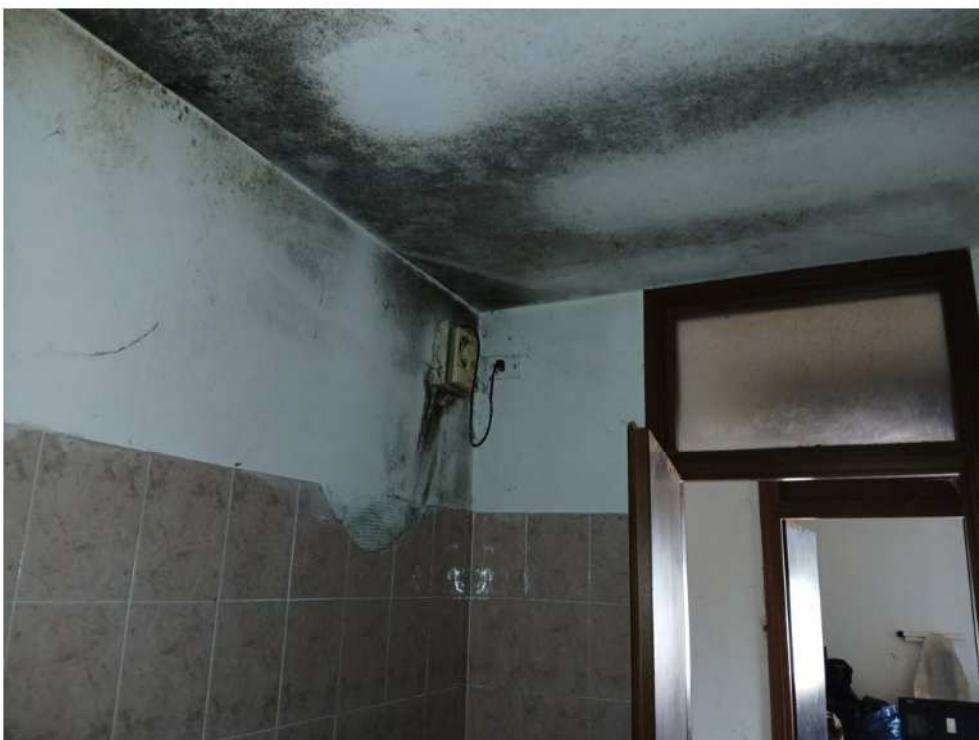
Bagno - particolare soffitto
