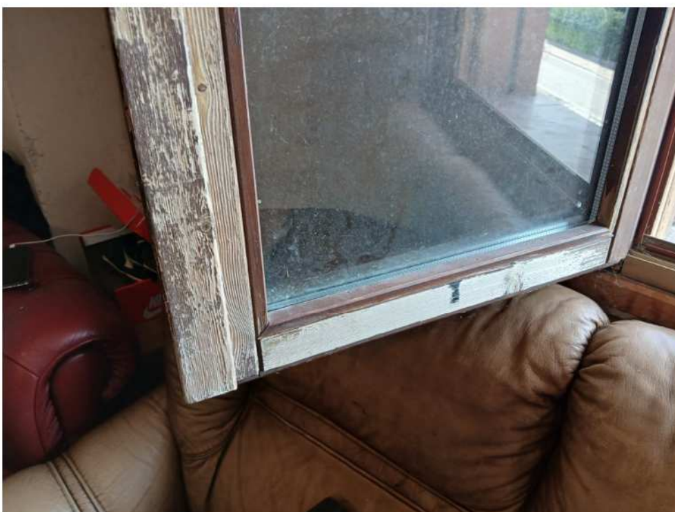
Particolare serramenti esterni
