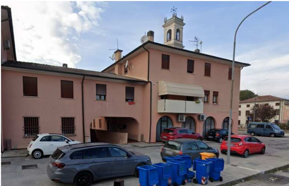
Vista prospetto Sud/Est
