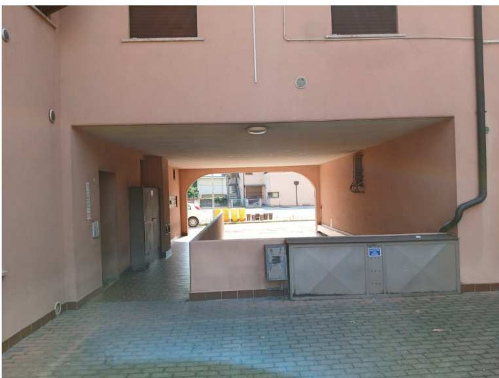
Vista ingresso condominiale lato Ovest dal cortile interno
