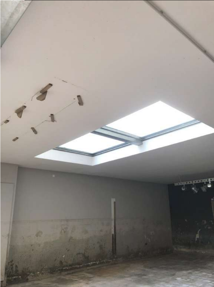
Foto 19- Piano 1° seminterrato – mostra
