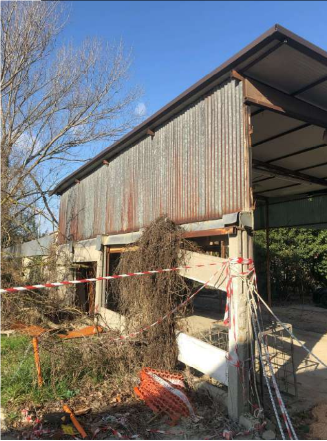
Foto 27- Piano S1/ TERRA -Sub.17 Deposito
