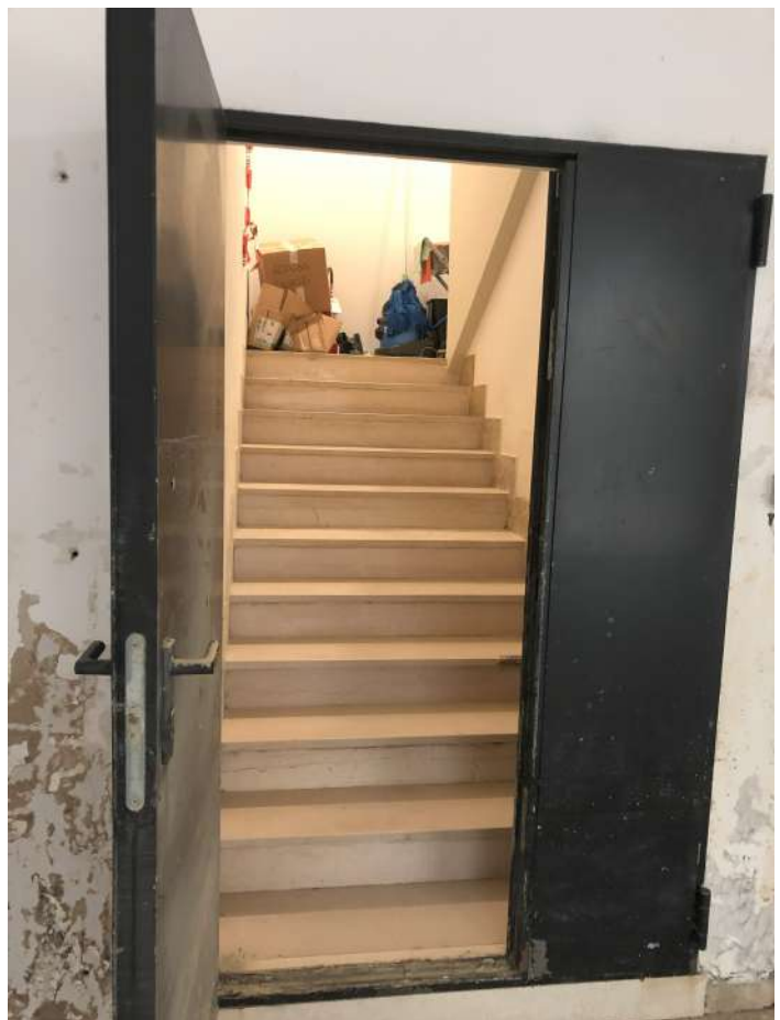
Foto 20- Piano 1° seminterrato – scala al piano terra
