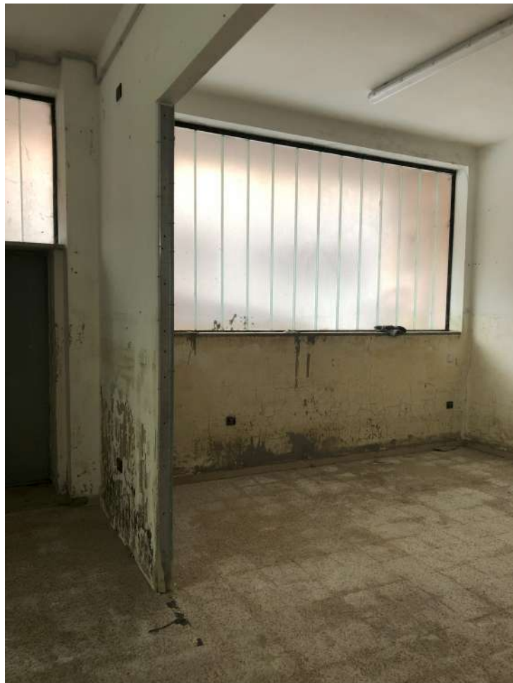
Foto 21- Piano 1° seminterrato – WC
