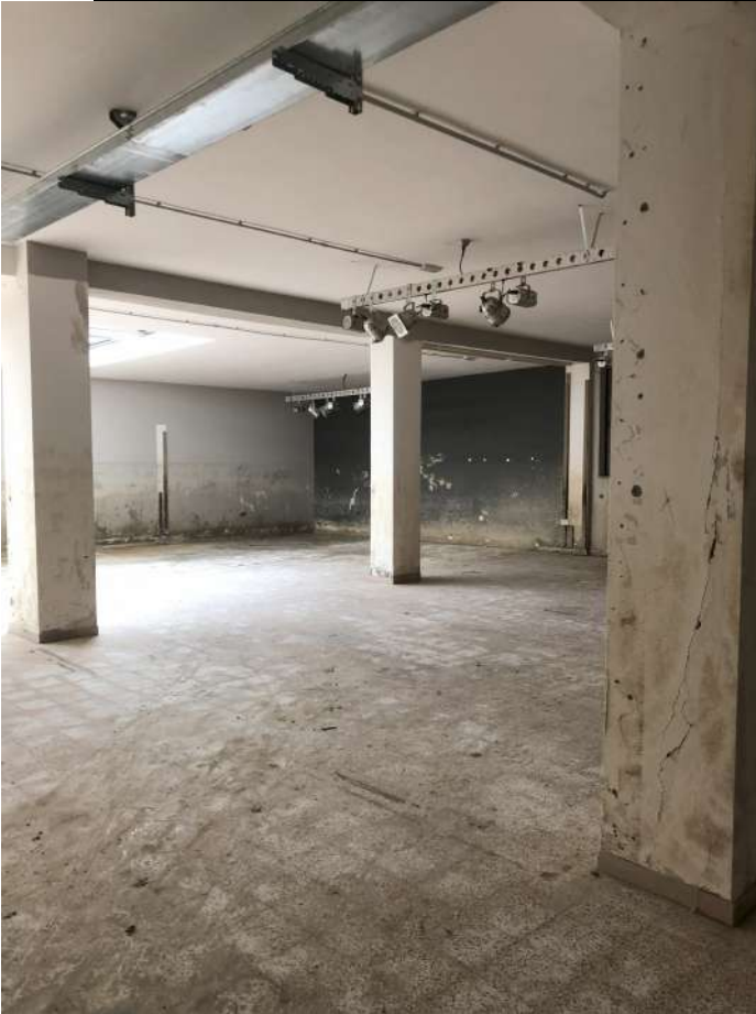
Foto 13- Piano 1° seminterrato – mostra
