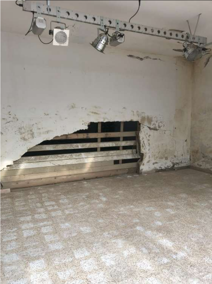
Foto 23- Piano 1° seminterrato – mostra
