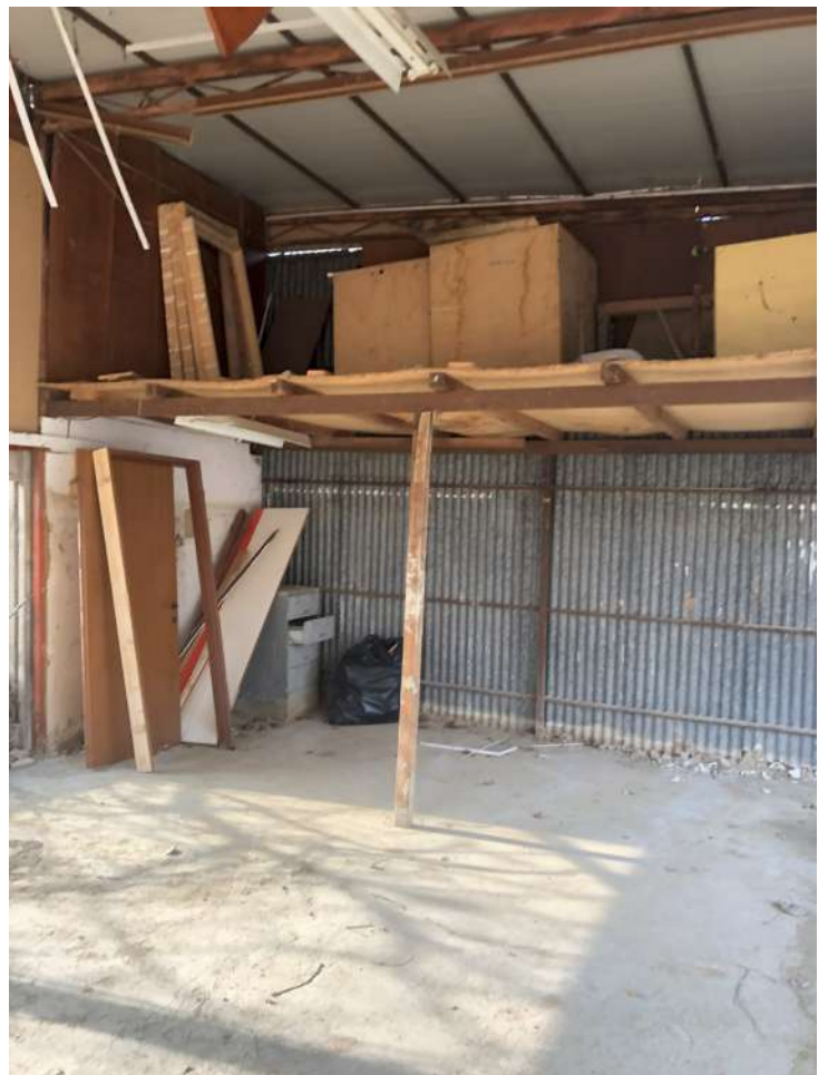
Foto 28- Piano S1/ TERRA -Sub.17 Deposito
