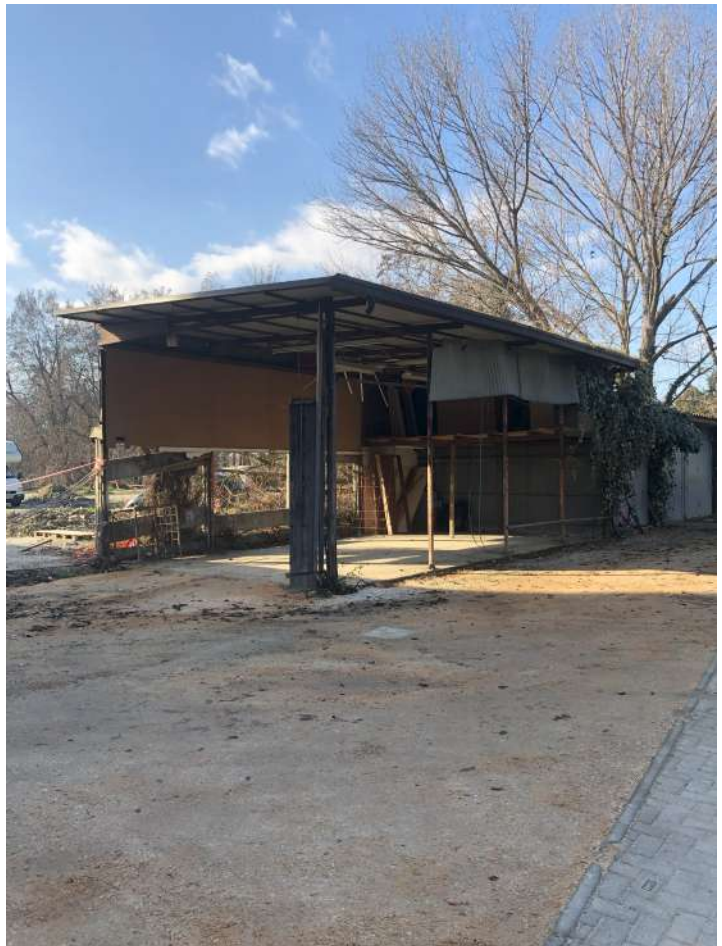
Foto 26- Piano S1/ TERRA -Sub.17 Deposito
