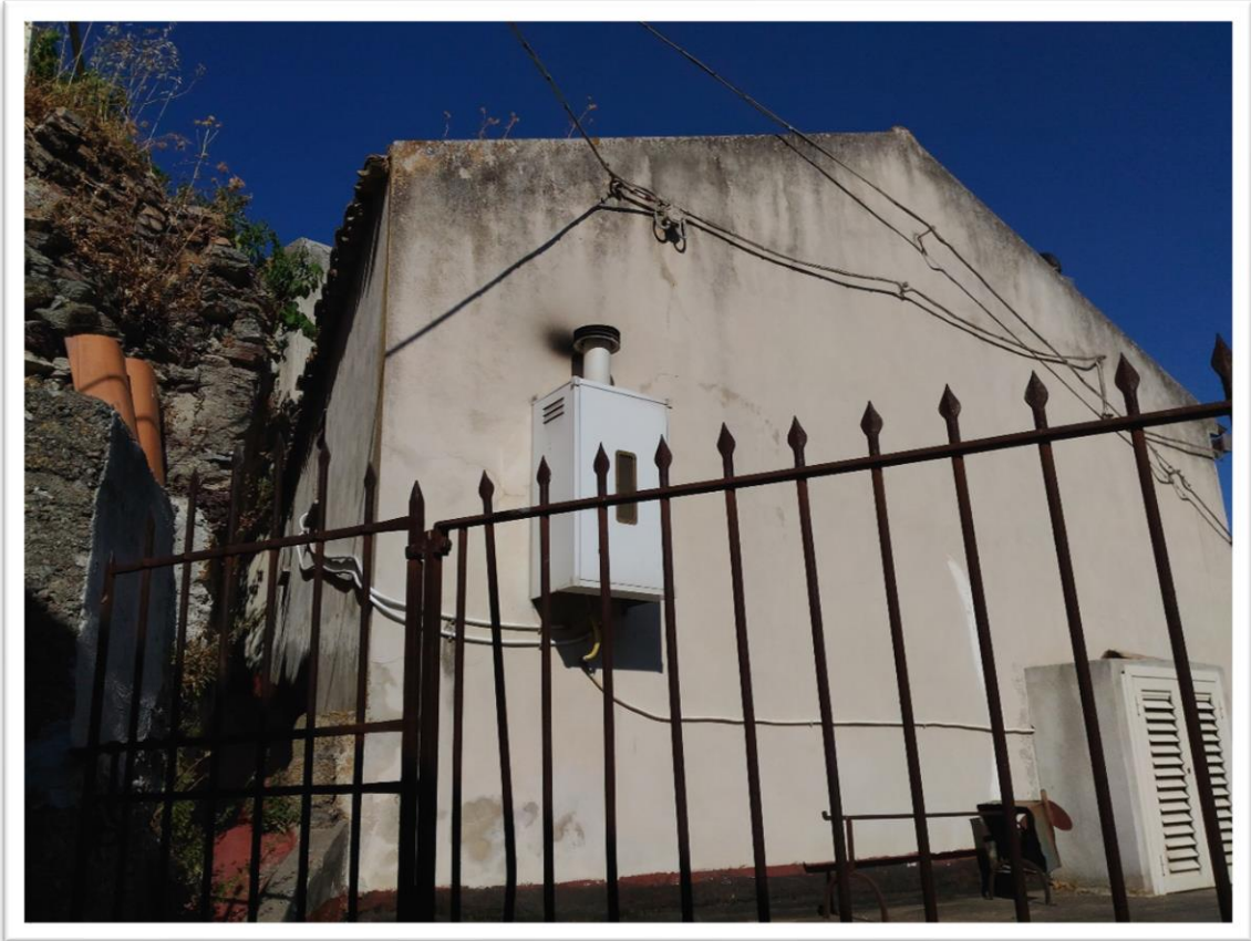
Foto n.26 – Immobile D: Roccalumera via Riposto - P.T e P.1°
