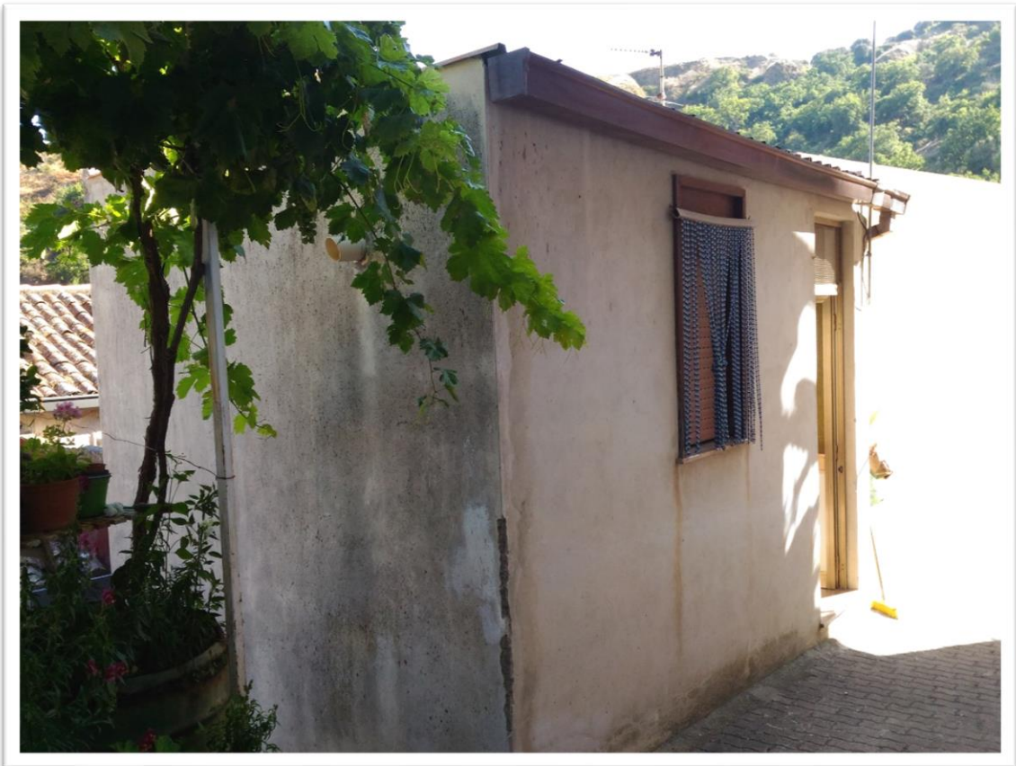
Foto n.27 – Immobile D: Roccalumera via Riposto - P.T e P.1°
