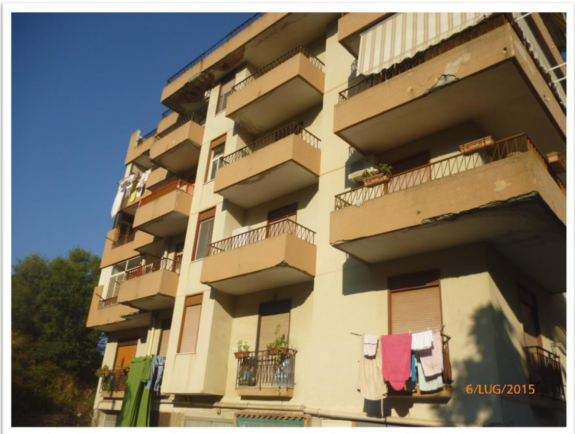
Foto n.021 – Immobile A: Ali Terme via Traversa di via Santa Lucia - P.3°
