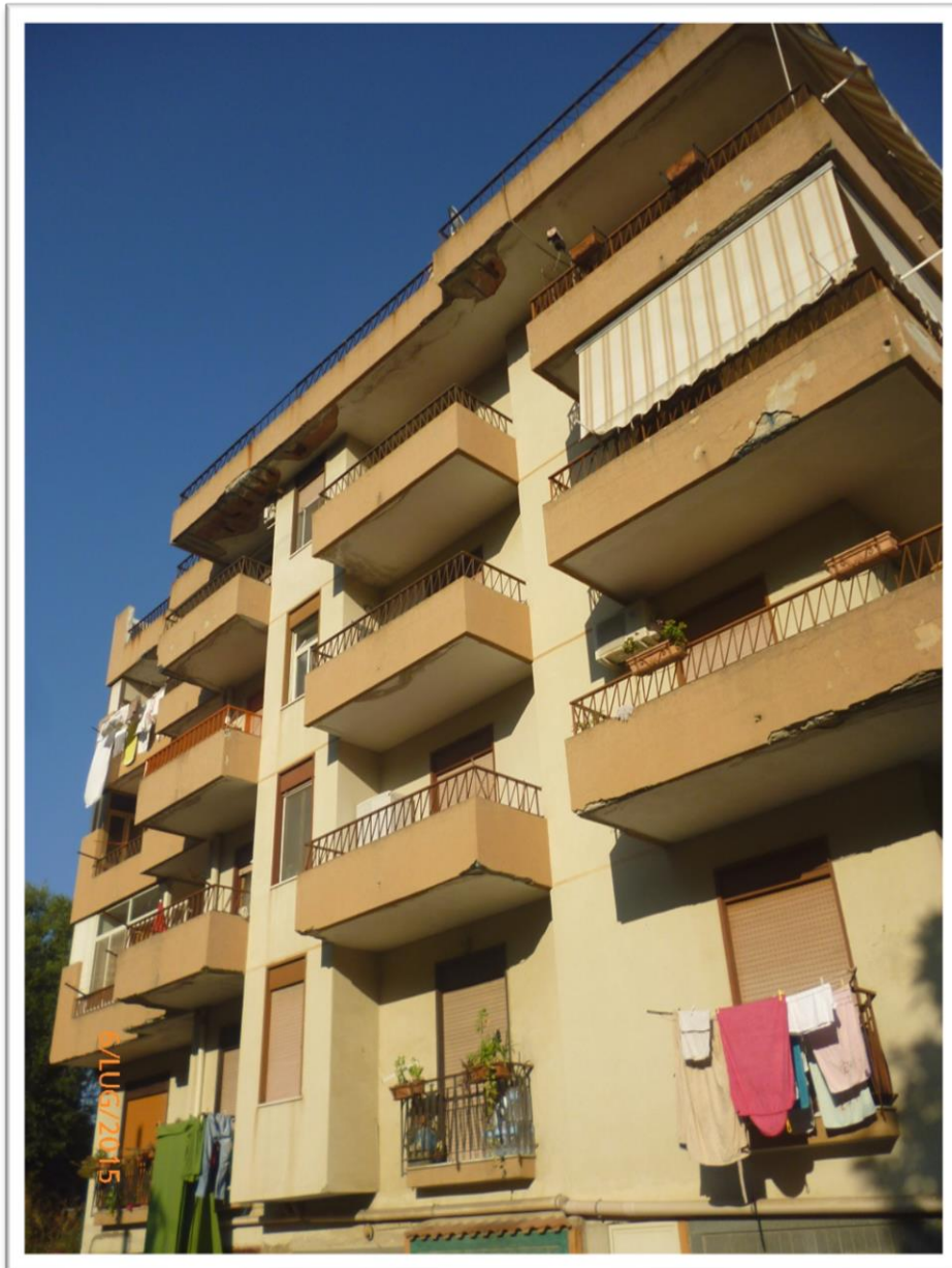
Foto n.03 – Immobile A: Ali Terme via Traversa di via Santa Lucia - P.3°
