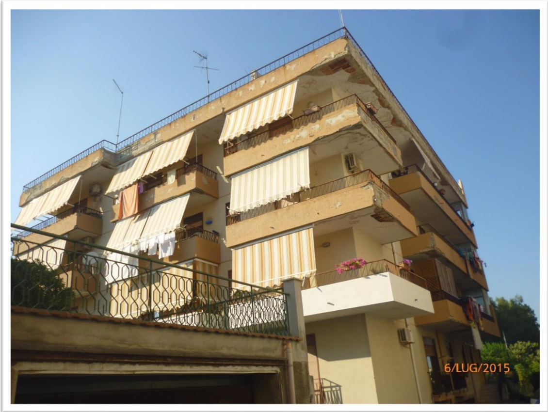
Foto n.01 – Immobile A: Ali Terme via Traversa di via Santa Lucia - P.3°
