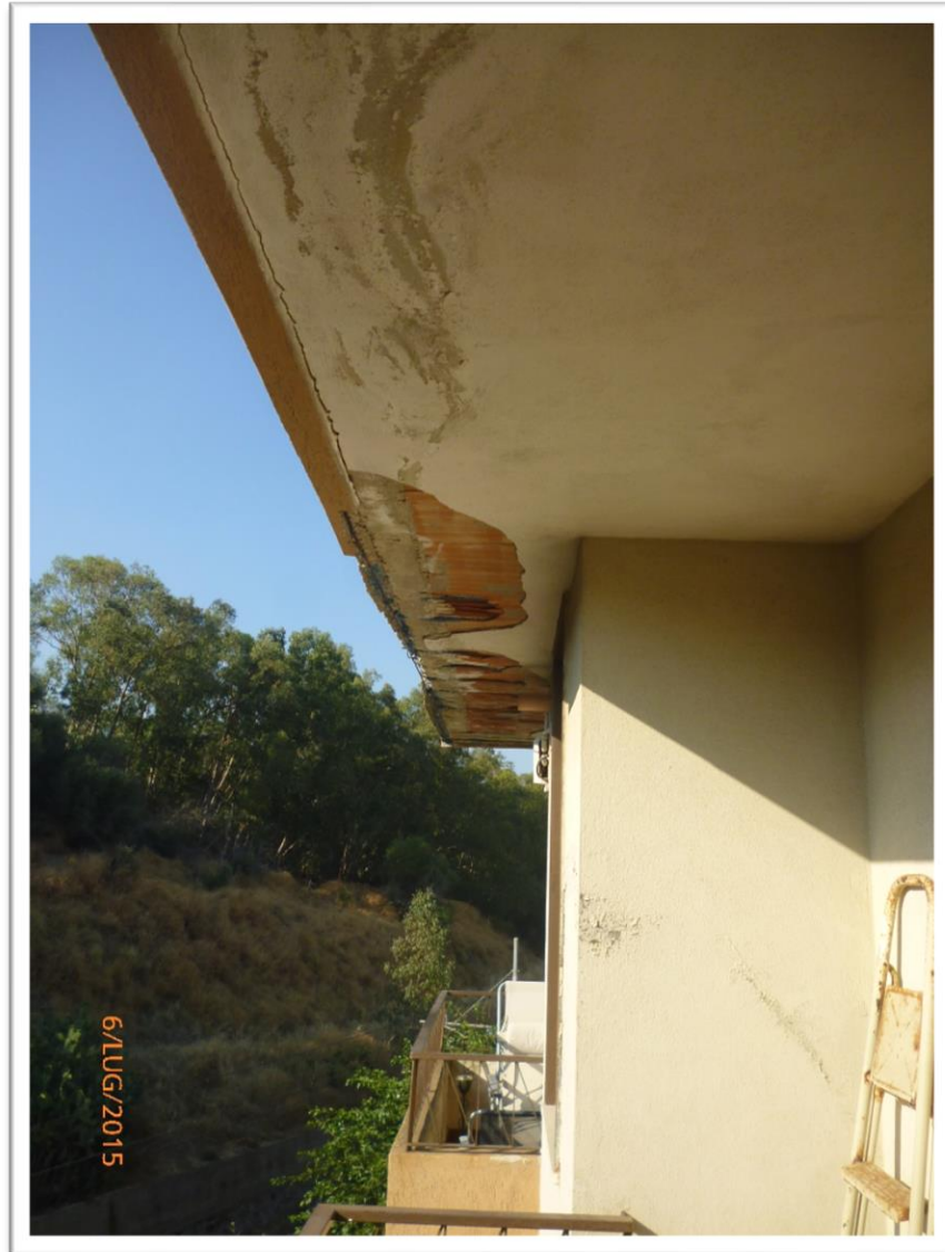
Foto n.11 – Immobile A: Ali Terme via Traversa di via Santa Lucia - P.3°
