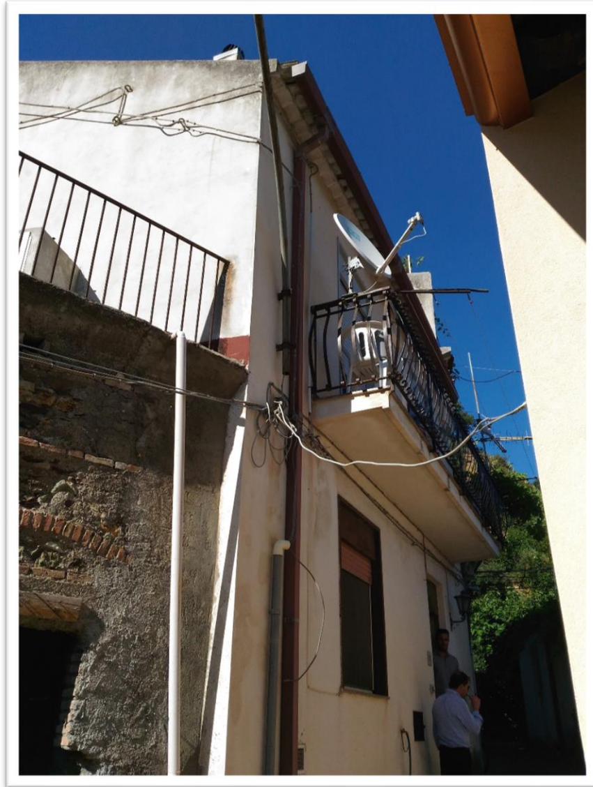
Foto n.25 – Immobile D: Roccalumera via Riposto - P.T e P.1°
