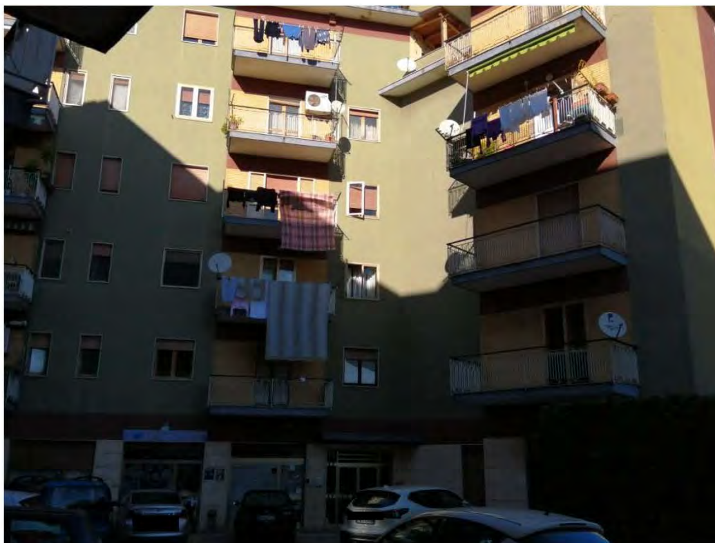
Foto n. 1 – prospetto sud del fabbricato lato ingresso
