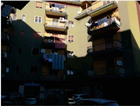
Foto n. 1 – prospetto sud del fabbricato lato ingresso
