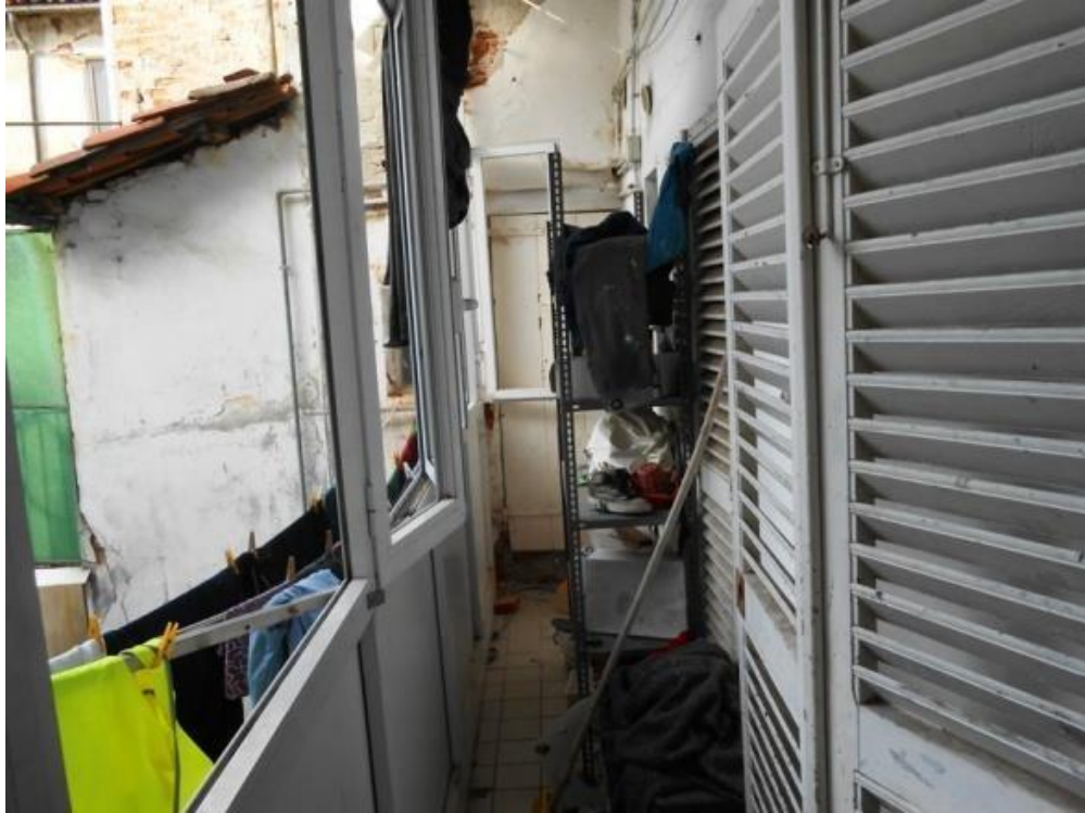
Figura 19 – balcone (lato Est) protetto con serramento
