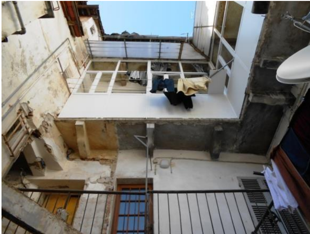
Figura 5 – Prospetto Est su cortile interno
