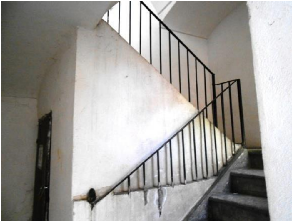
Figura 7 – scala condominiale di accesso dal cortile interno al piano secondo
