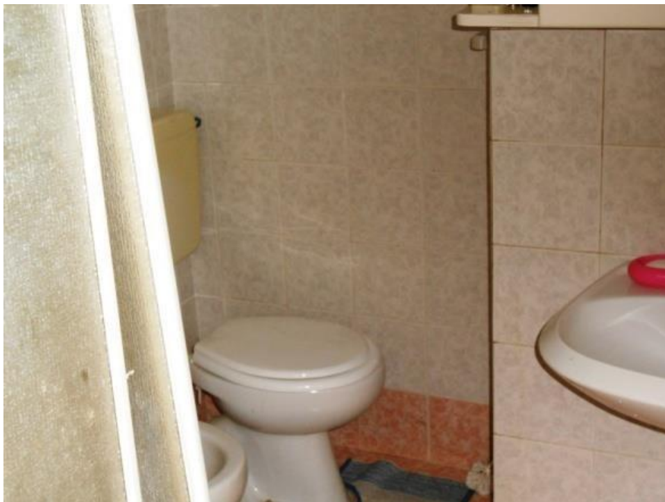
Figura 16 – Locale servizi igienici
