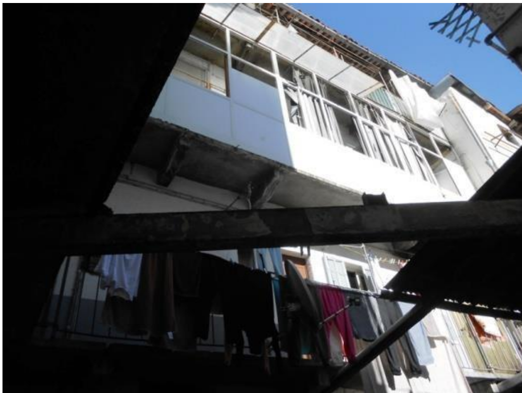
Figura 6 – Prospetto Sud su cortile interno
