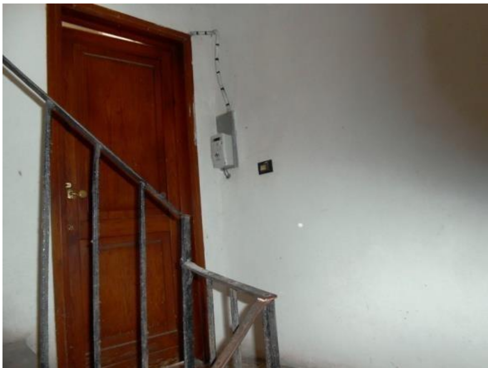
Figura 10 – Porta di accesso all'alloggio al piano secondo
