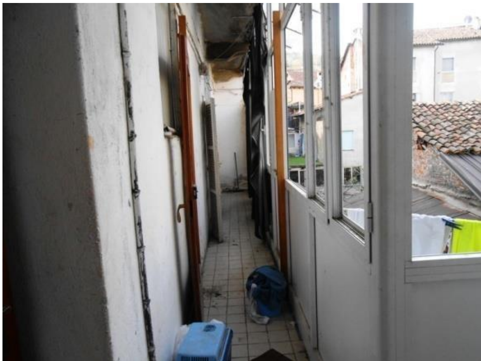
Figura 18 - balcone (lato Sst) protetto con serramento
