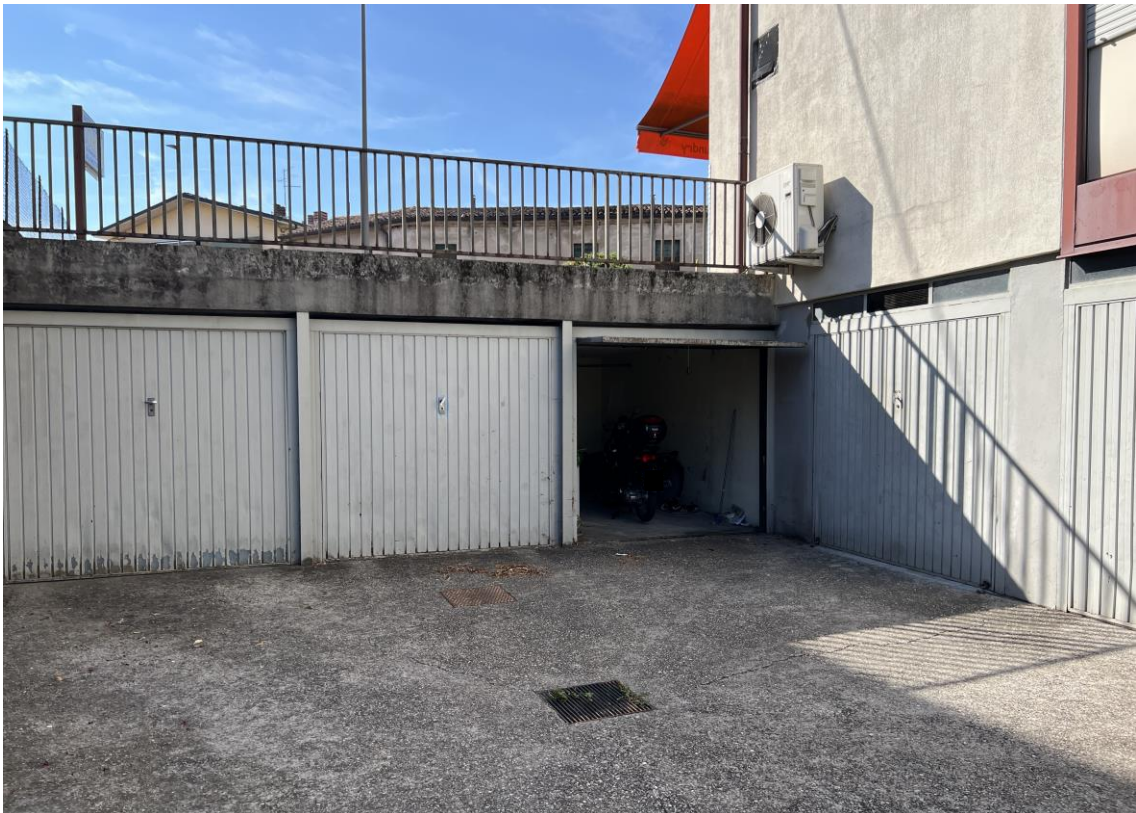
Sub. 27 – Vista dell'esterno
