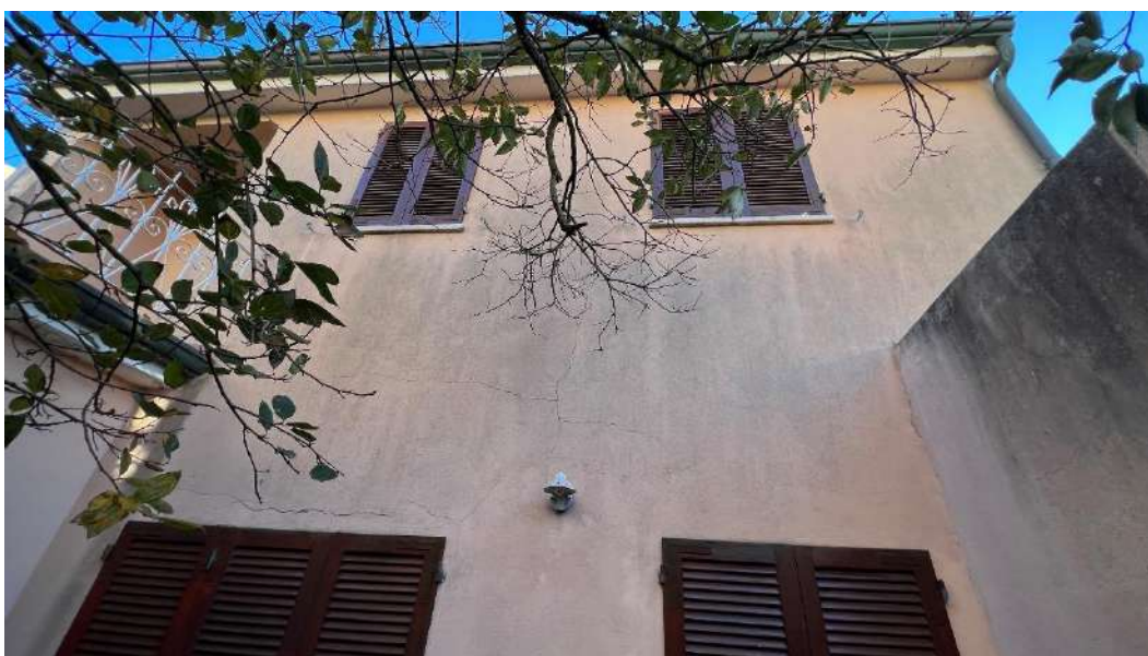
Figura 3 – Viste del cortile e della facciata posteriore
