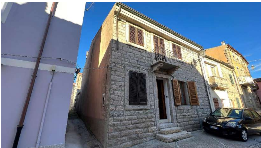
Figura 1 – Viste del fronte strada del fabbricato
