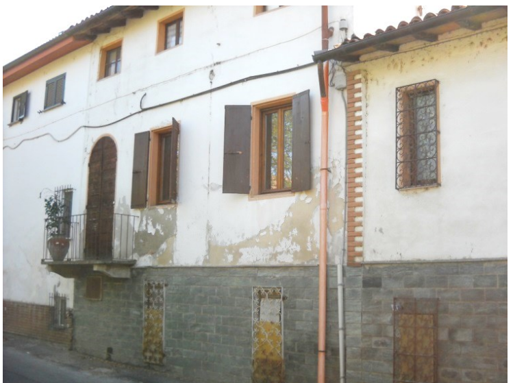
Prospetto da Via dei Mori
