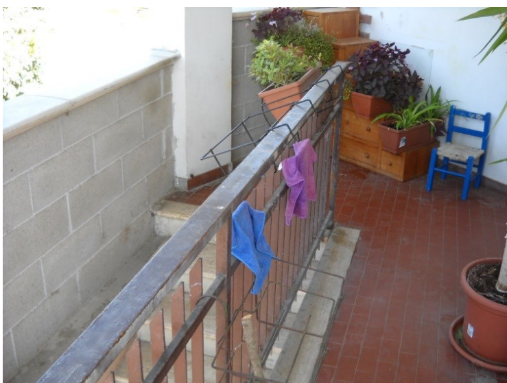
Accesso esterno alloggio piano primo.
