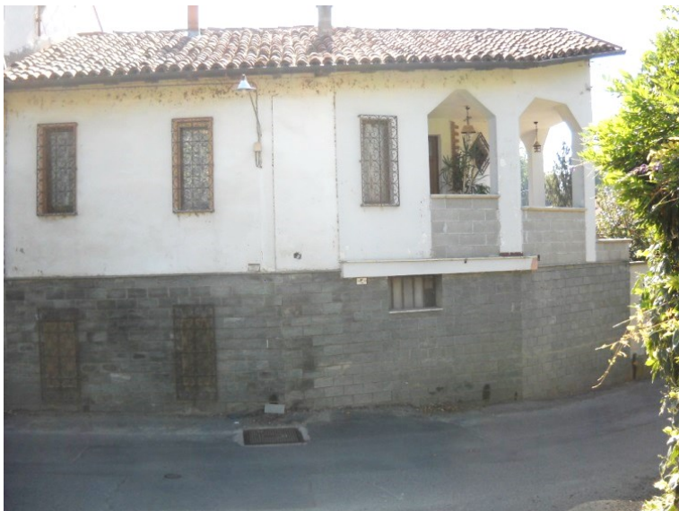
Prospetto da Via dei Mori
