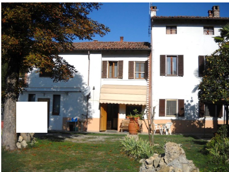
Prospetto da cortile interno
