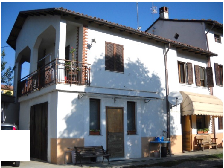
Prospetto da cortile interno
