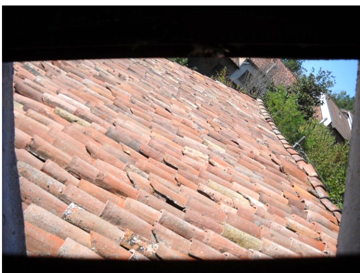
Manto di copertura in coppi
