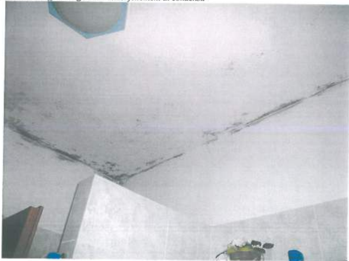
FOTO N° 37 – soffitto bagno con estesi fenomeni di condensa
