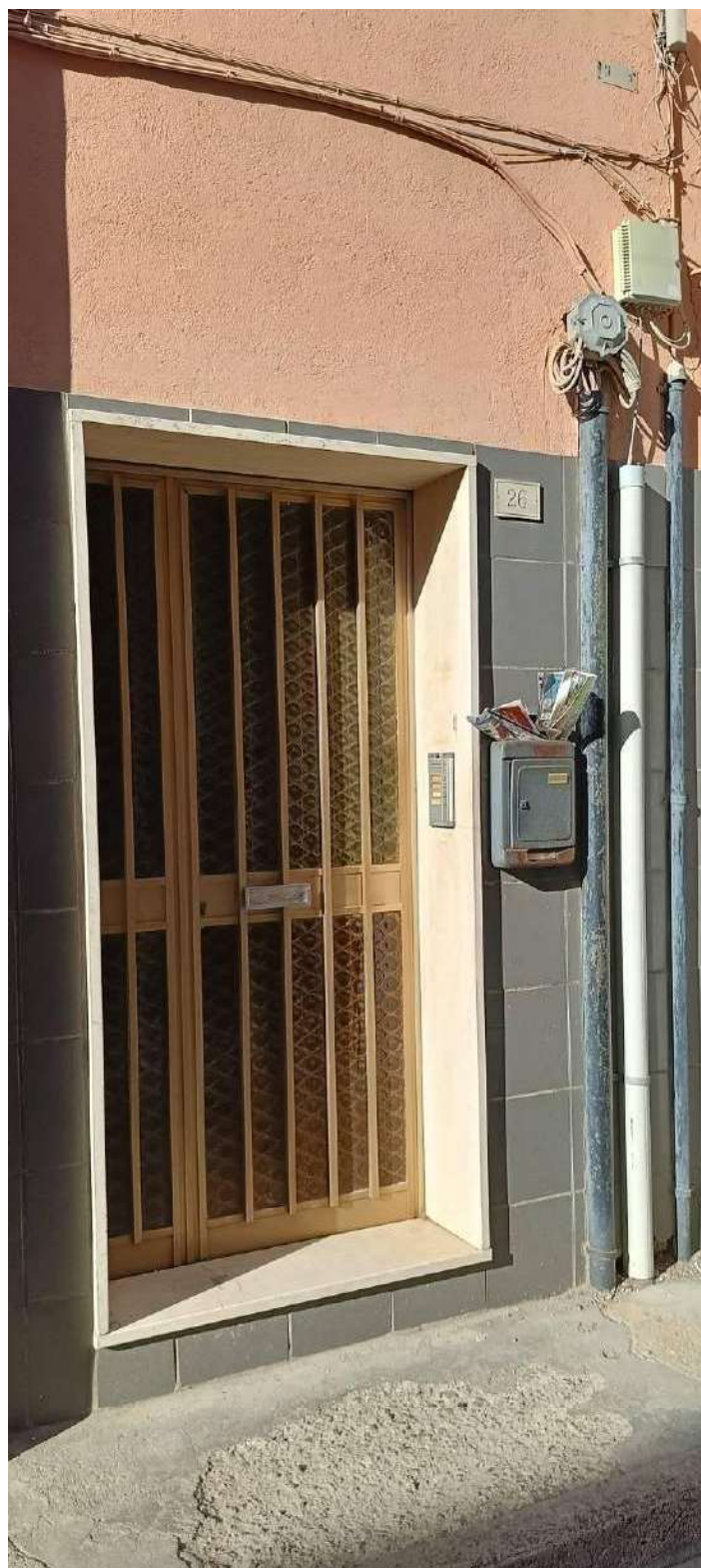
FOTO 18. Ingresso appartamento piano terzo
