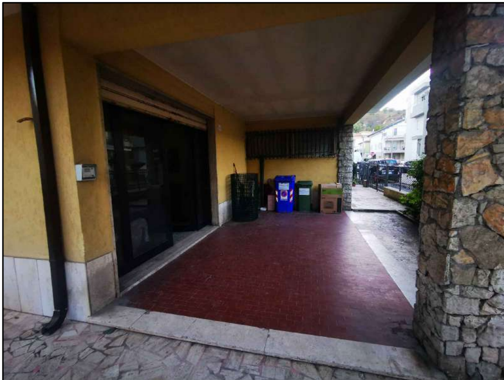
Vista esterna - portico e corte esterna
