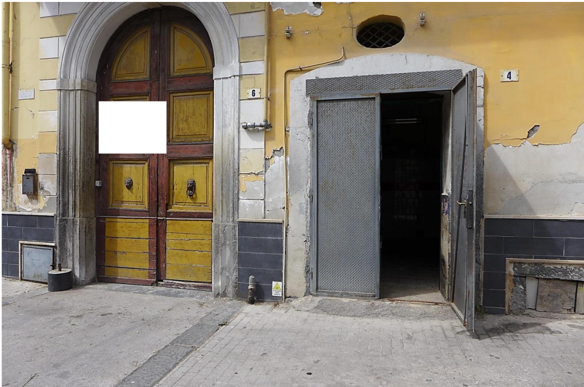
Ingresso Lotto n. 1 = SUB 1 (Via Castello n. 4)
