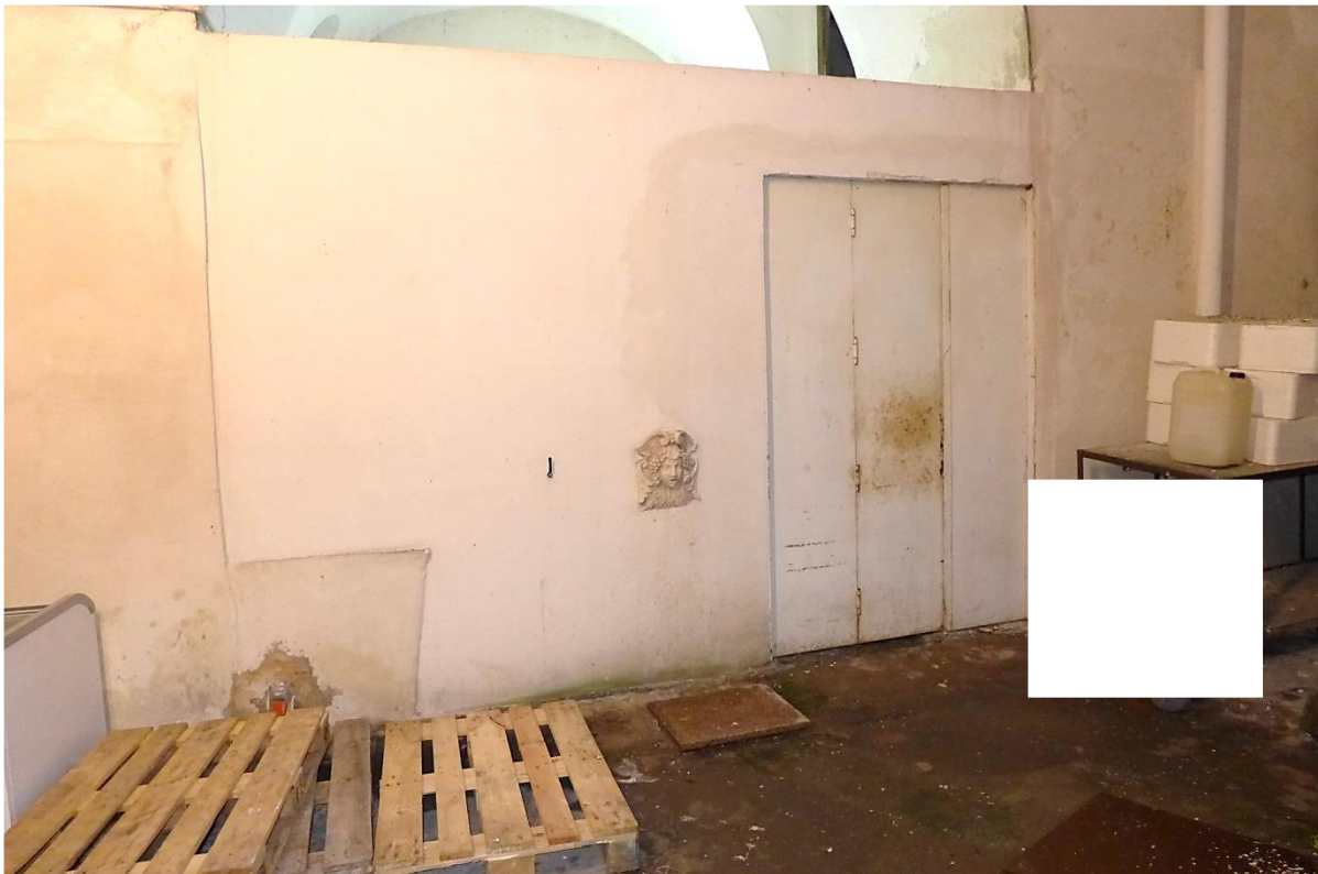
Ingresso secondario Lotto n. 2 = SUB 2 + SUB 3 (area cortilizia Via Castello n. 6)
