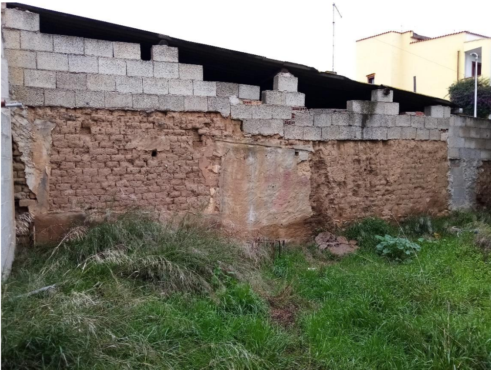
foto 16 – muratura di recinzione cortile lato Nord – Est
