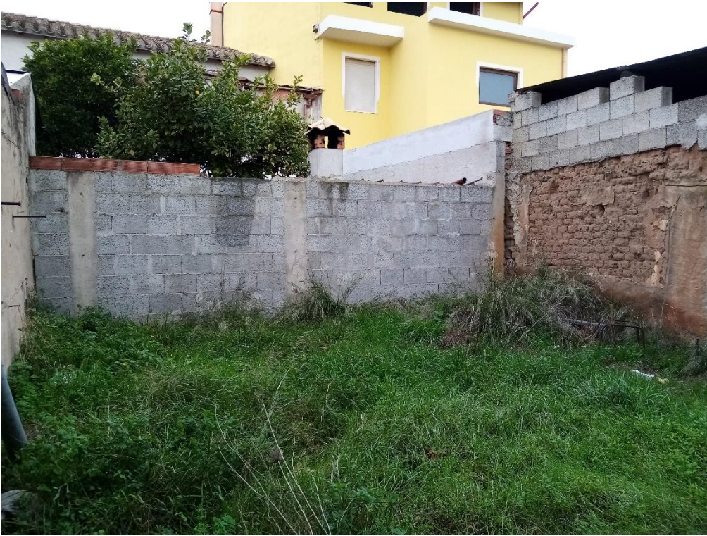
foto 17 – muratura di recinzione confine opposto
