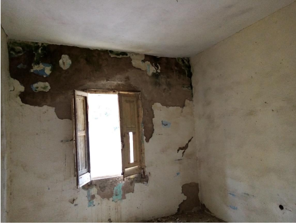
foto 9 - vano al piano primo
