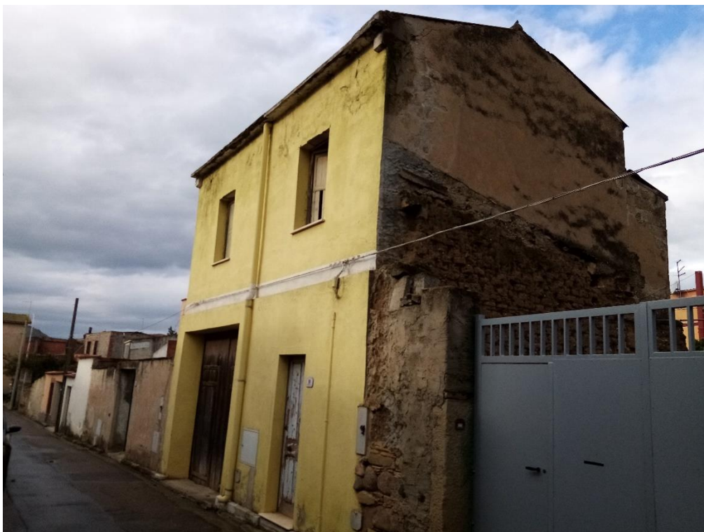
foto 1 – prospetto fronte strada
