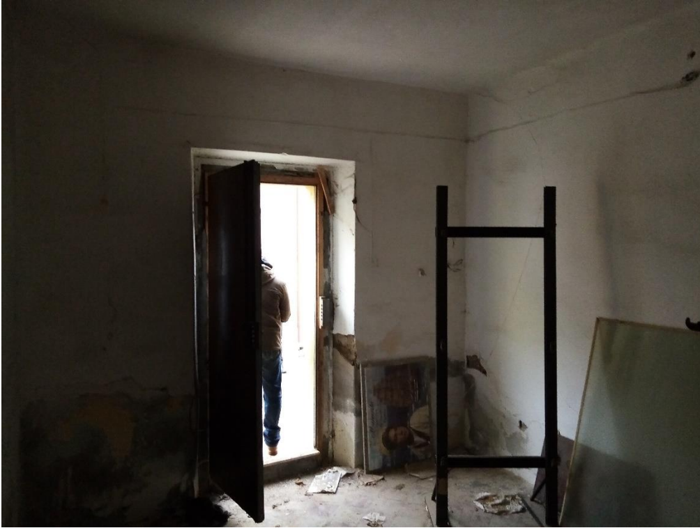
foto 7 - vano al piano terreno - accesso dalla strada
