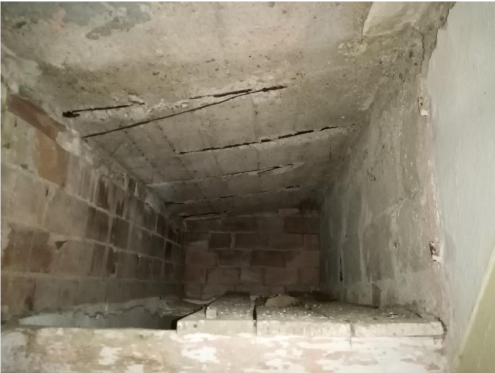
foto 14 - soffitto vano scala
