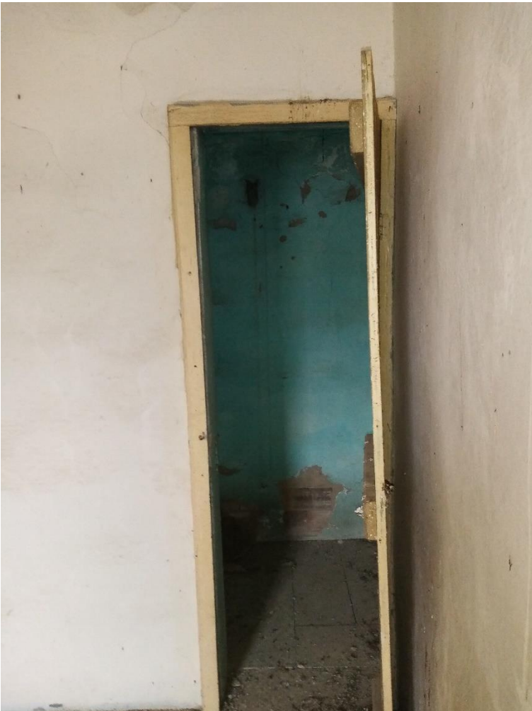
foto 12 - ripostiglio al piano primo
