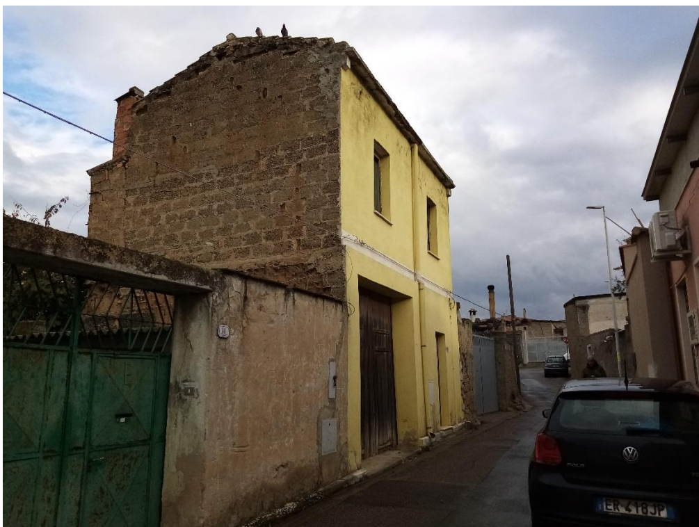
foto 2 – prospetto fronte strada
