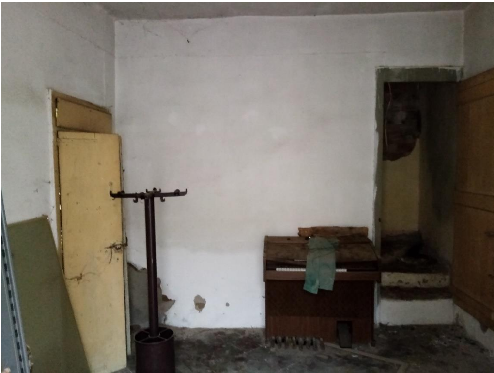
foto 6 - vano al piano terreno verso accesso alla scala
