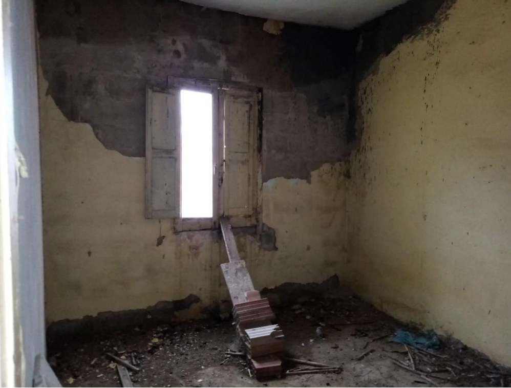
foto 13 - vano al piano primo
