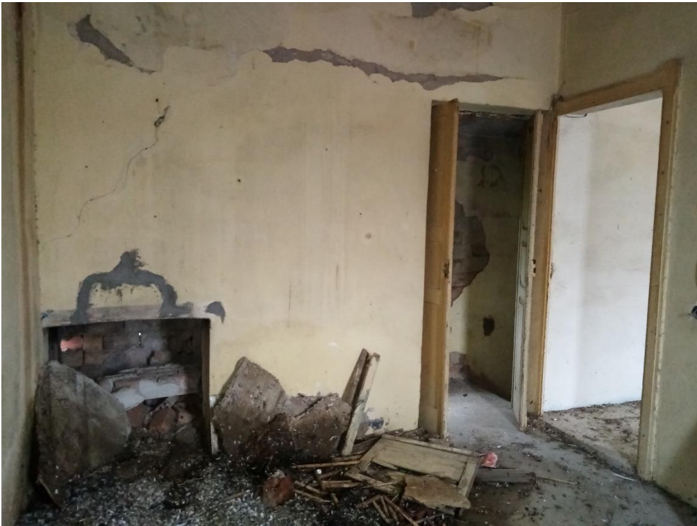
foto 10 - vano al piano primo
