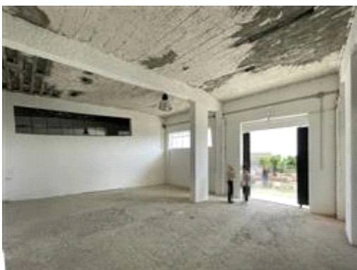
Interno del locale deposito
