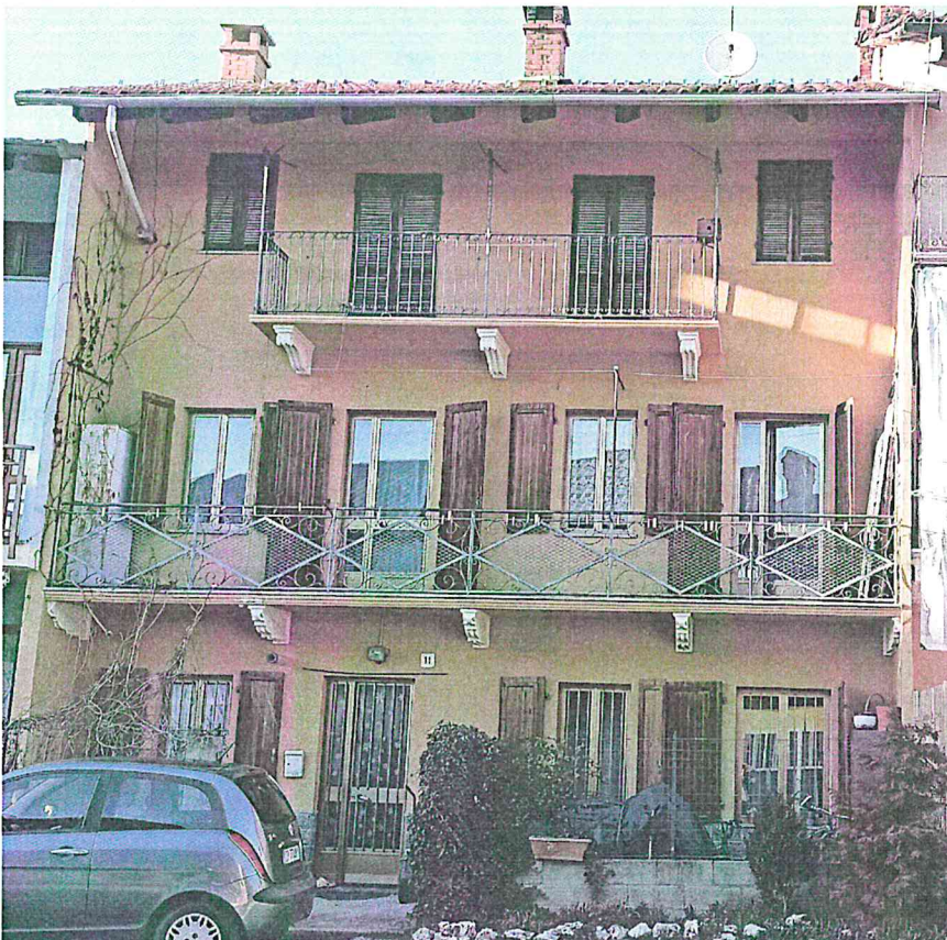
Foto 2 Vista esterna lato cortile
