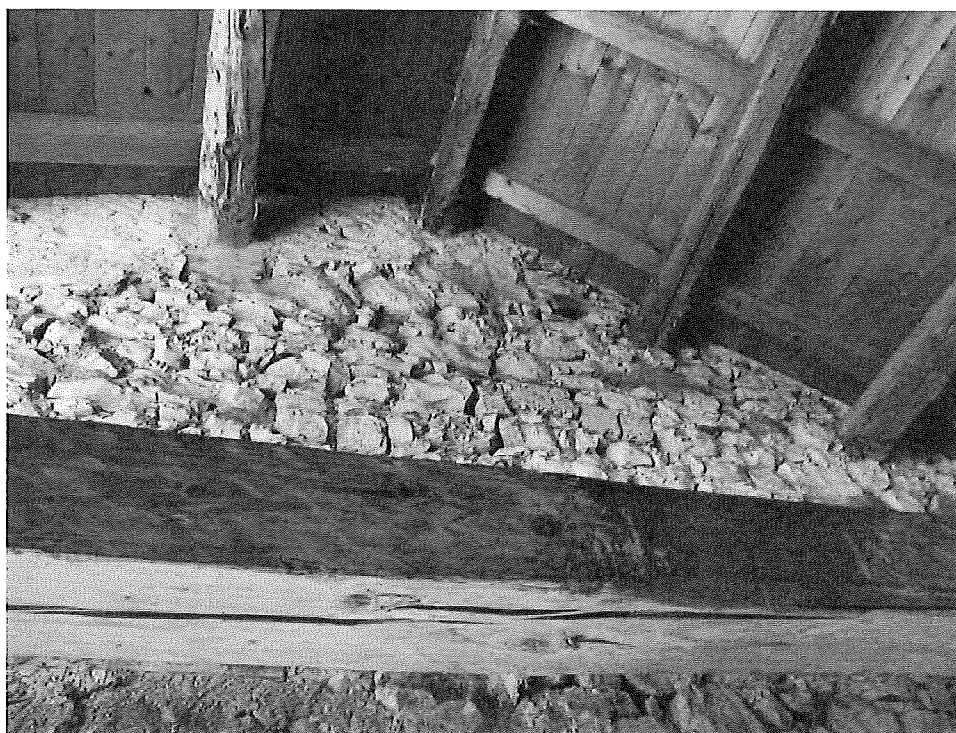
Dettaglio della struttura lignea della copertura a livello sottotetto
