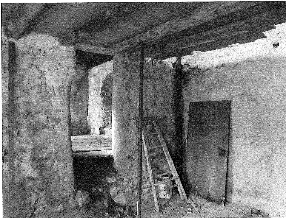
Stanza a piano terra corpo particella 421
