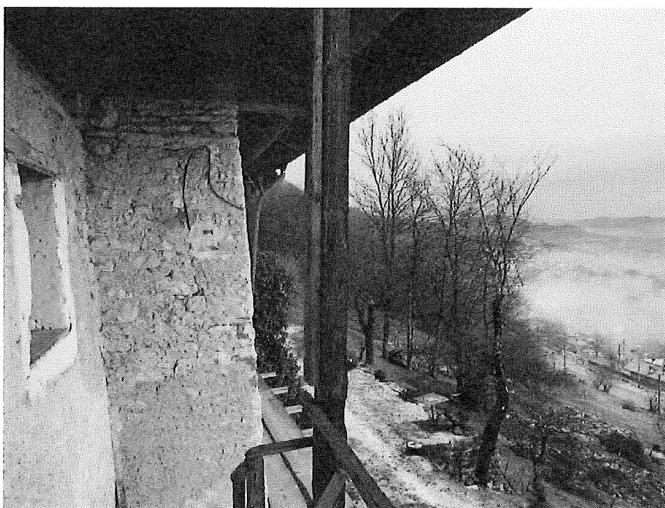
Dettaglio da terrazza piano primo
