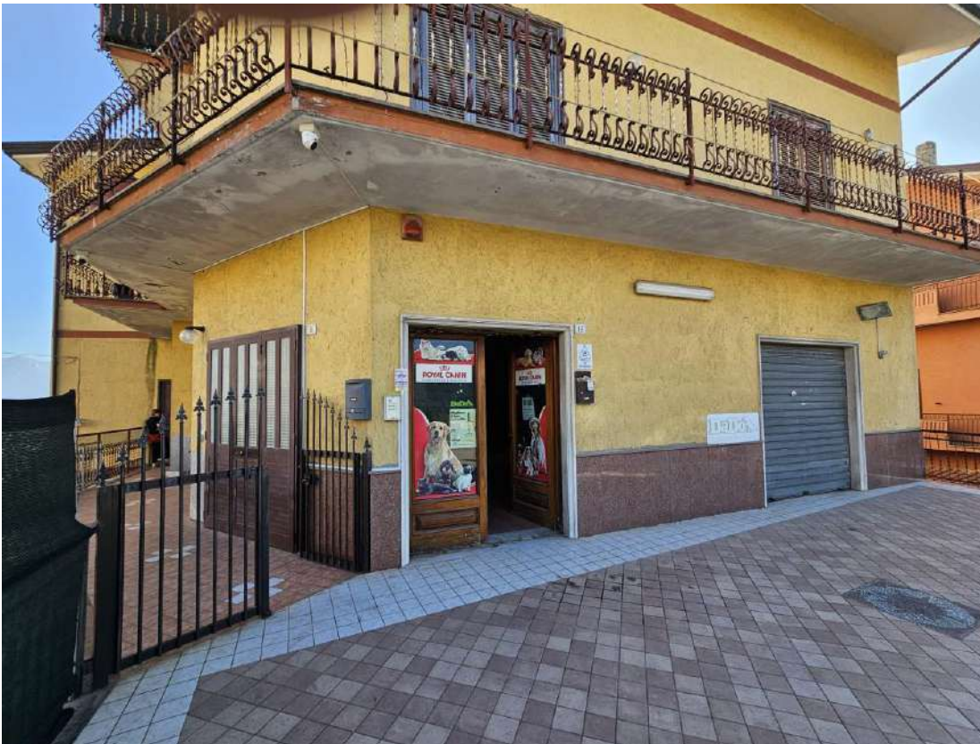
Ingresso al locale commerciale con spazio antistante
