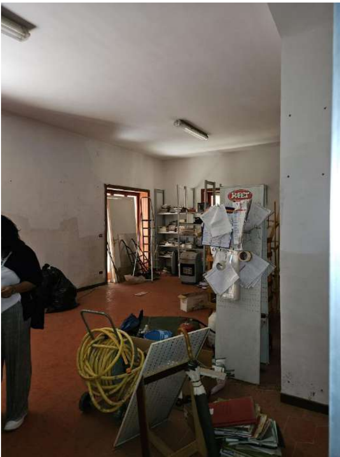
Interno Locale commerciale grande-retronegozio separato da parete in cartongesso
