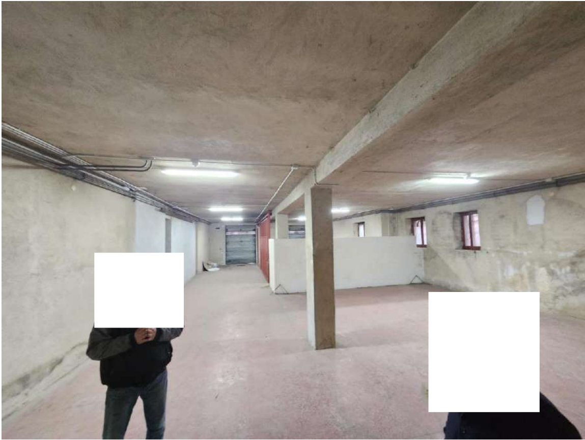
Interno Locale deposito grande con divisioni interne
