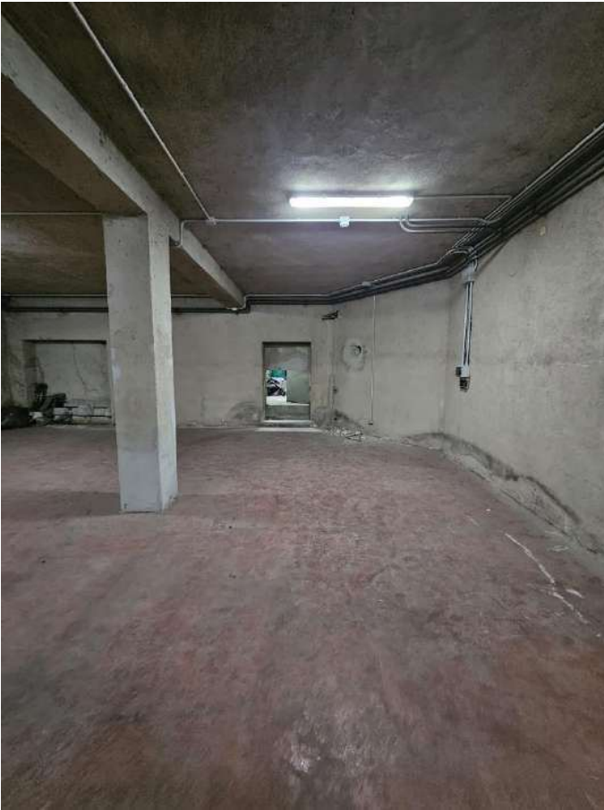
Interno Locale deposito grande-accesso alla legnaia posteriore
