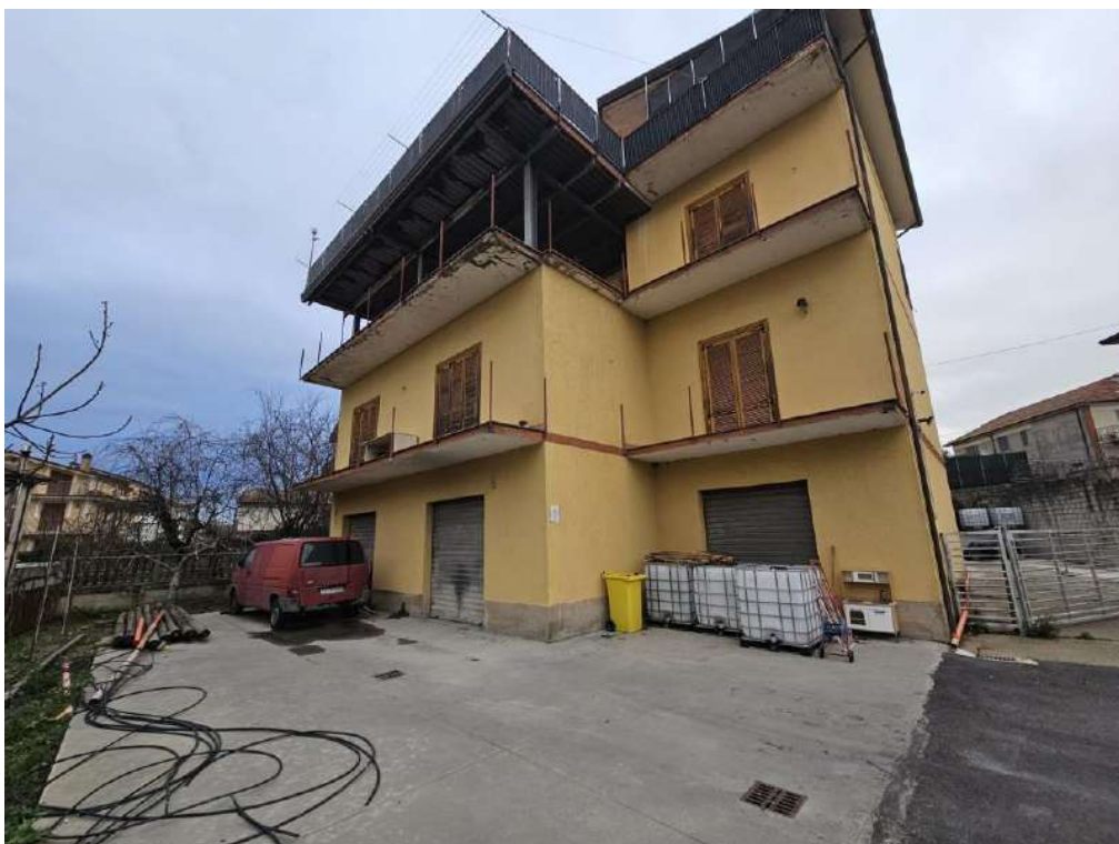
Prospetto posteriore con i tre ingressi al locale deposito
