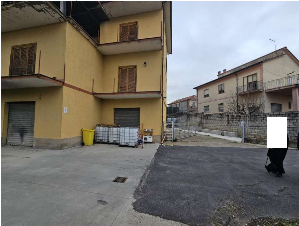
Ingresso Locale deposito piccolo con divisioni interne
