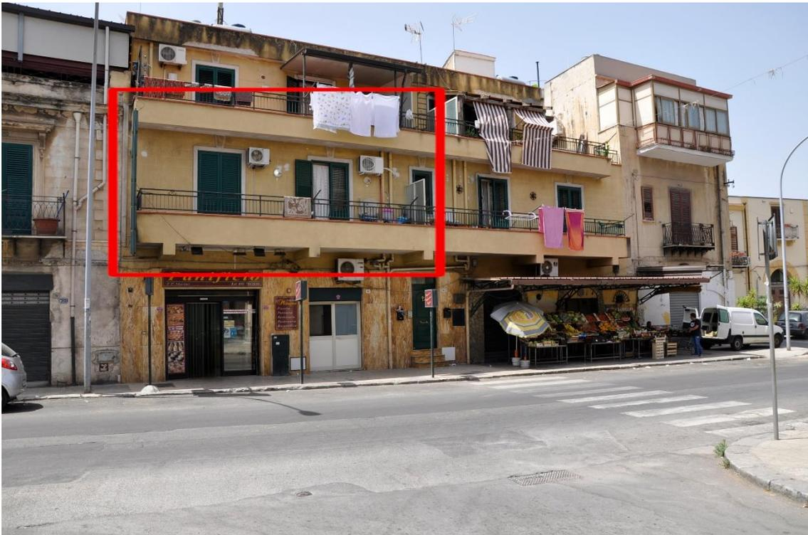
palazzina a 3 elevazioni fuori terra originariamente realizzata in muratura (piano terra e primo) e successivamente ampliata con cordoli di rinforzo e strutture portanti intelaiate in c.c.a, solai interpiano misti in ferro, cemento e laterizio, murature di tompagnamento e tramezzatura in blocchi di tufo e/o cemento pomice.
