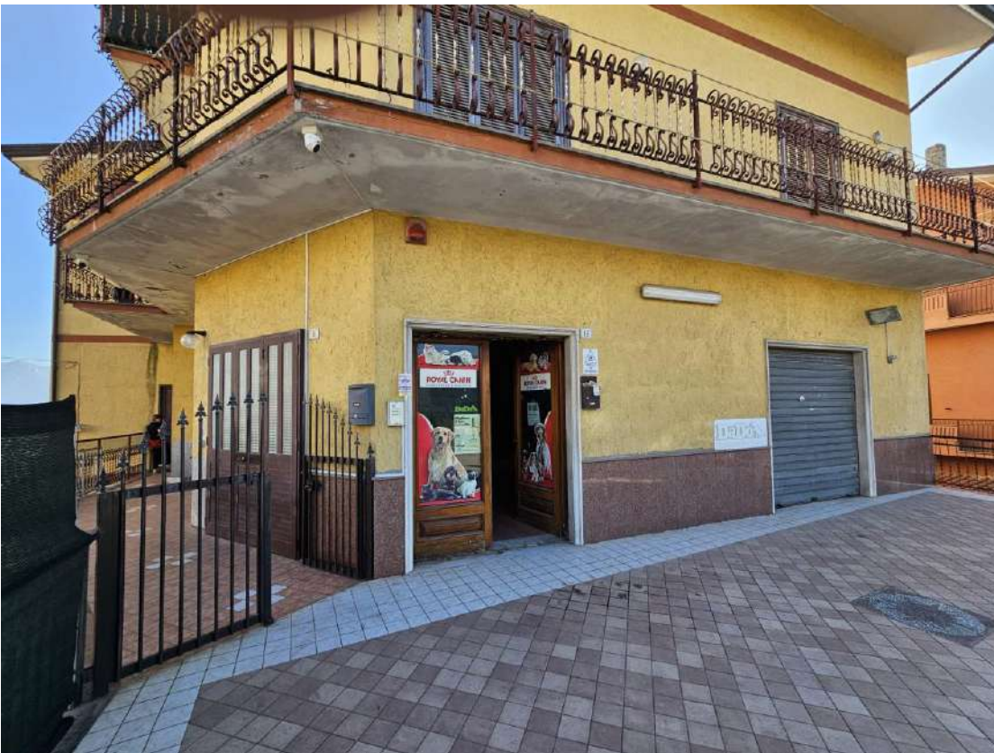
Ingresso al locale commerciale con spazio antistante
