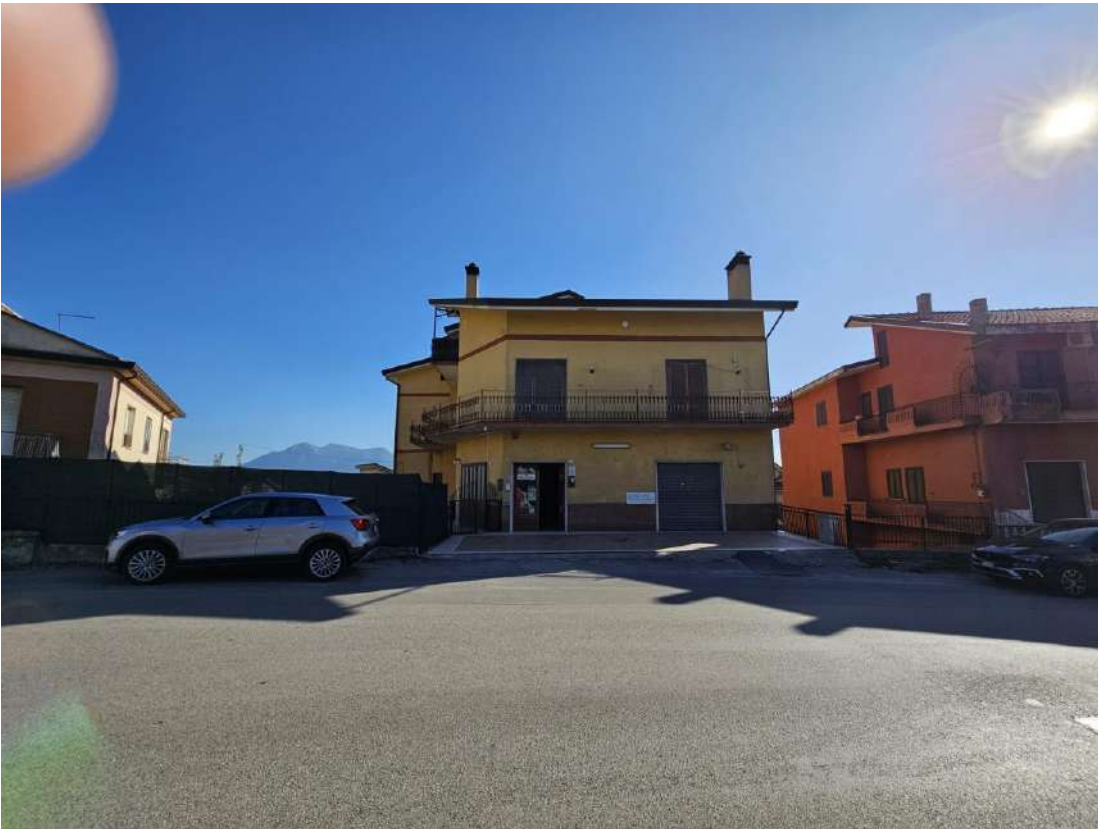
Prospetto principale a nord su viabilità comunale
