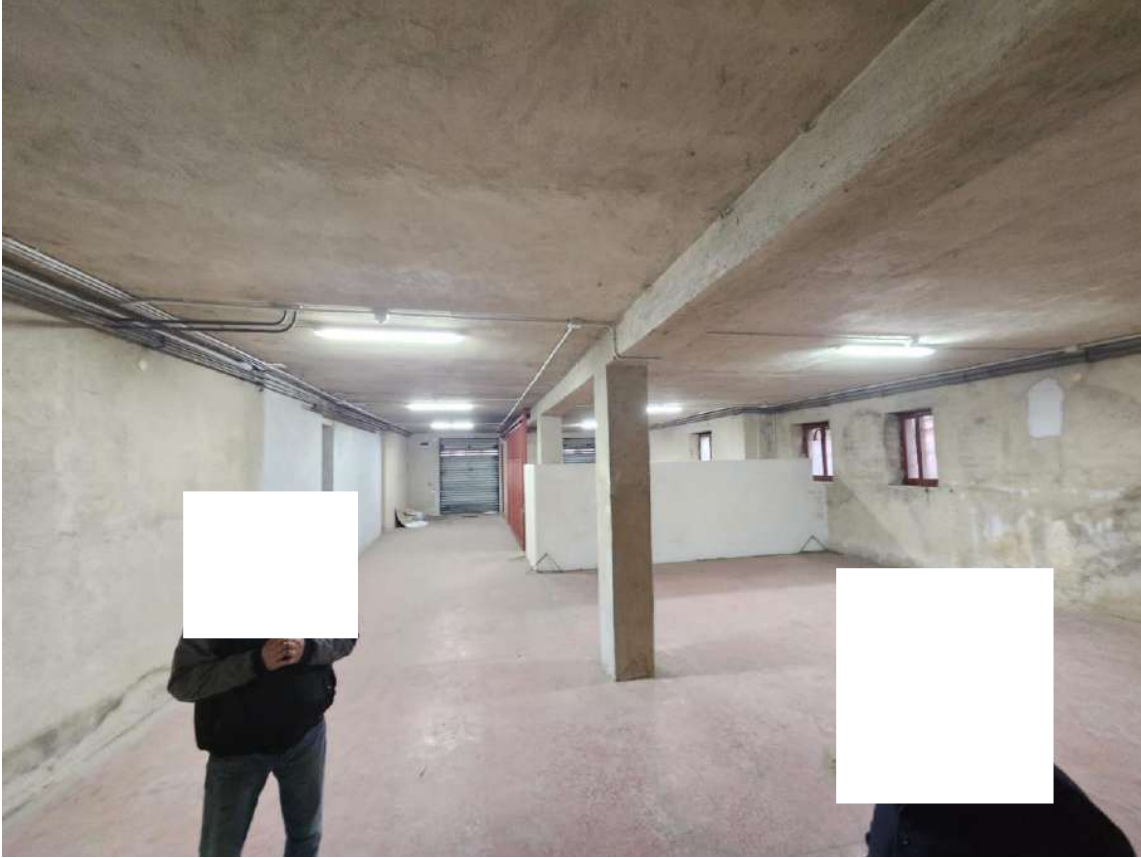
Interno Locale deposito grande con divisioni interne
