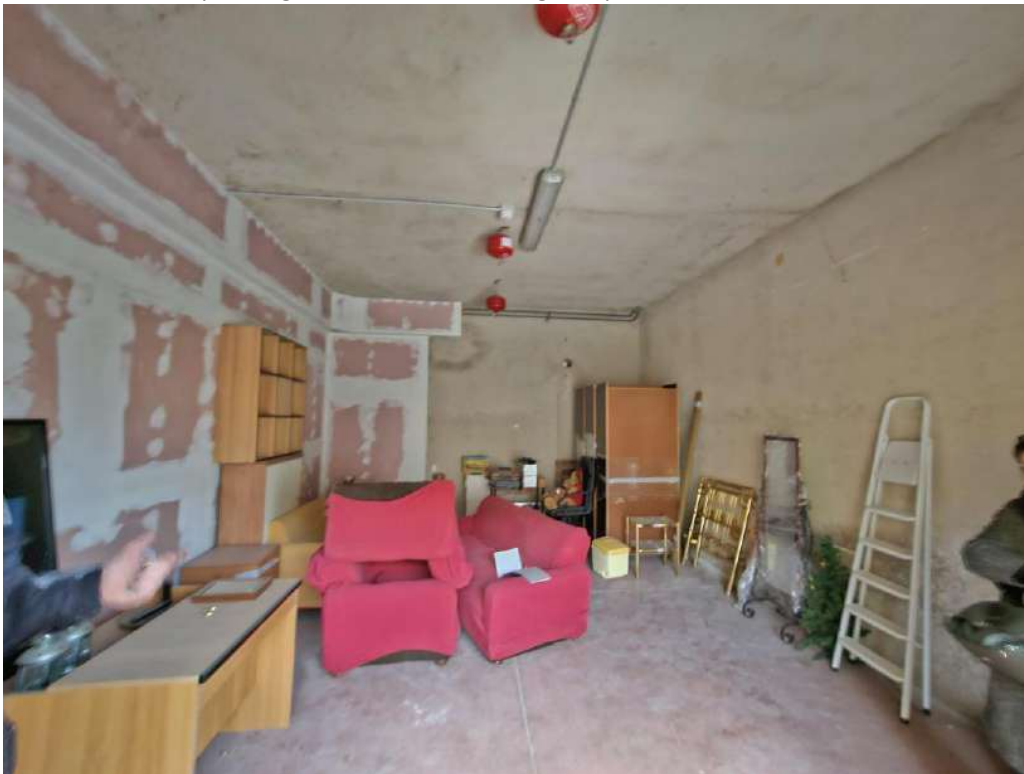
Locale deposito piccolo separato dal resto con parete in cartongesso
