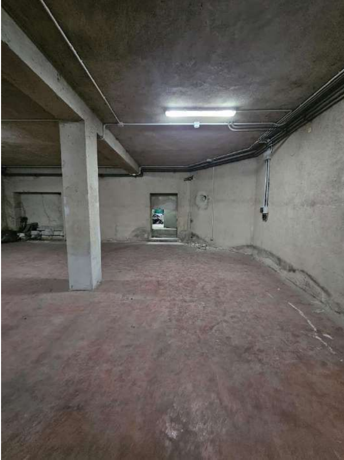
Interno Locale deposito grande-accesso alla legnaia posteriore
