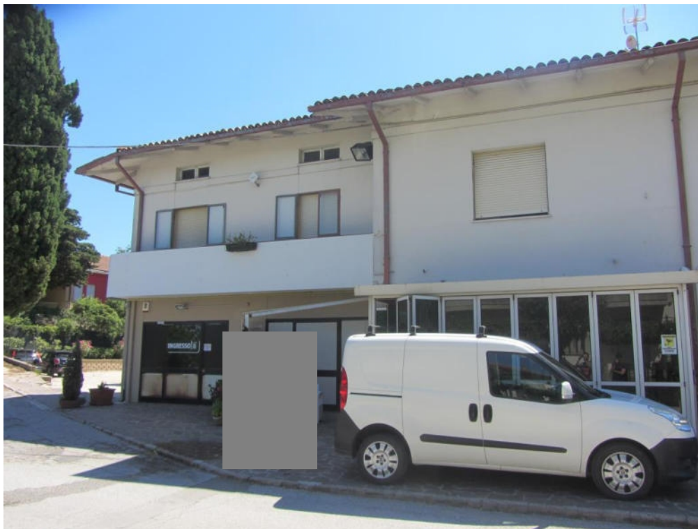
FOTO E.03_ ESTERNO
