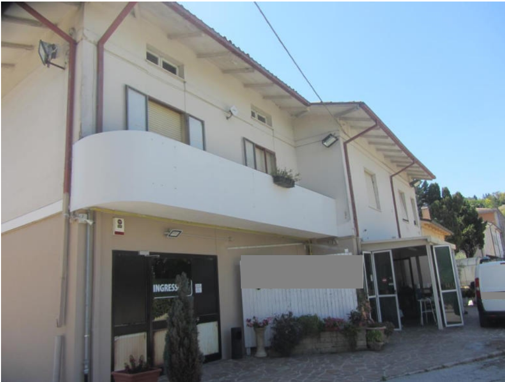
FOTO E.01_ ESTERNO
