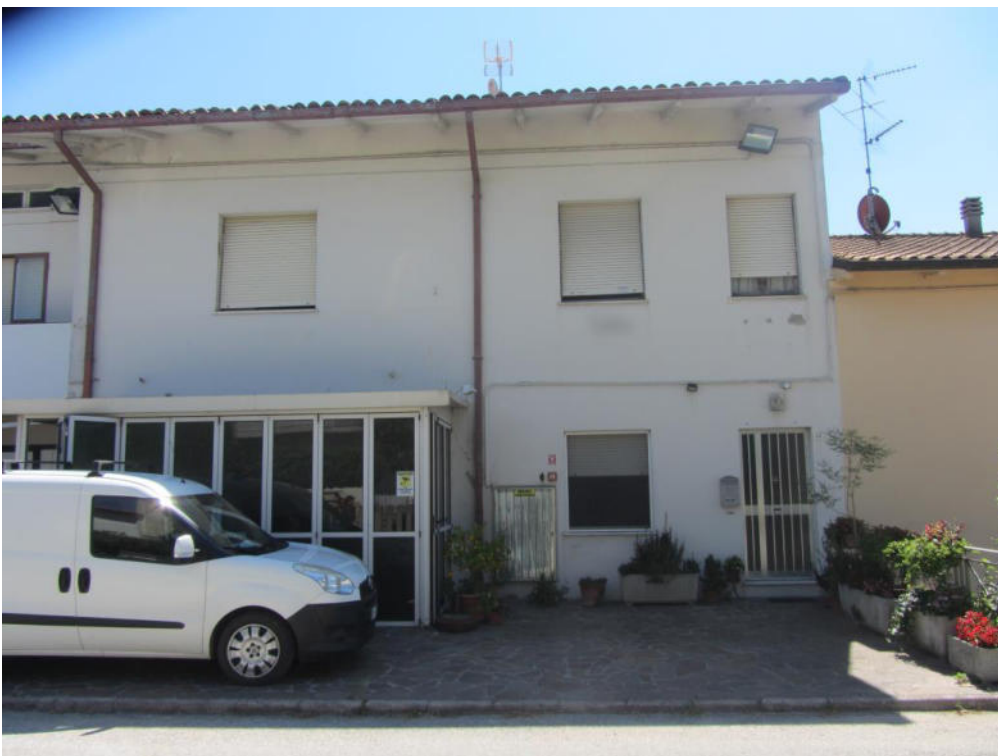
FOTO E.02_ ESTERNO
