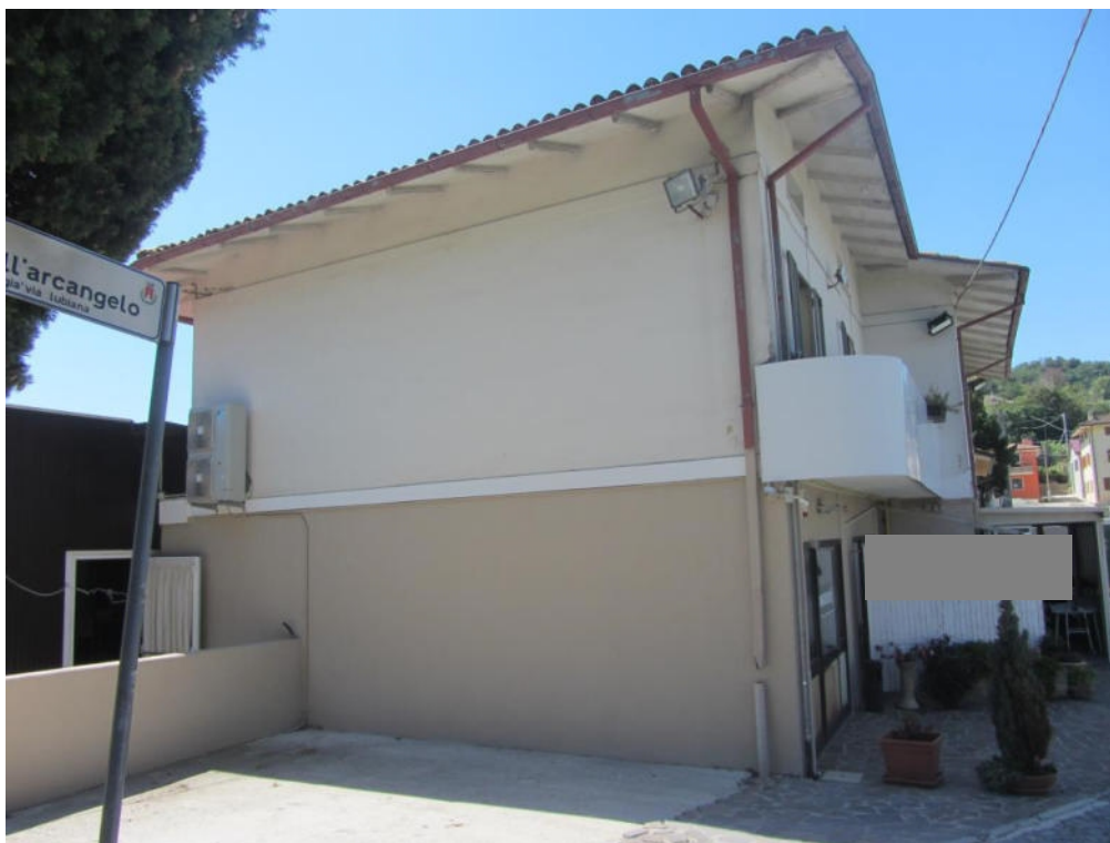
FOTO E.04_ ESTERNO
