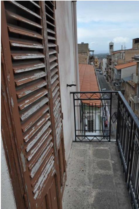
Foto 28 – Balcone di P. 3°, vista su via Ferrara
