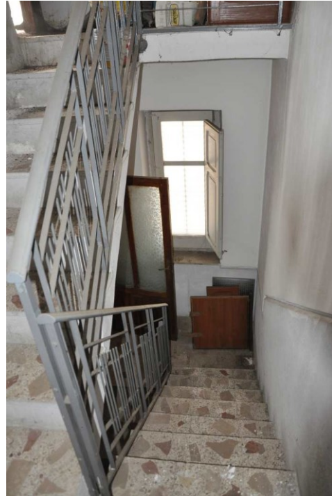
Foto 29 - Corpo scala, rampa tra P.3° e P.4°
