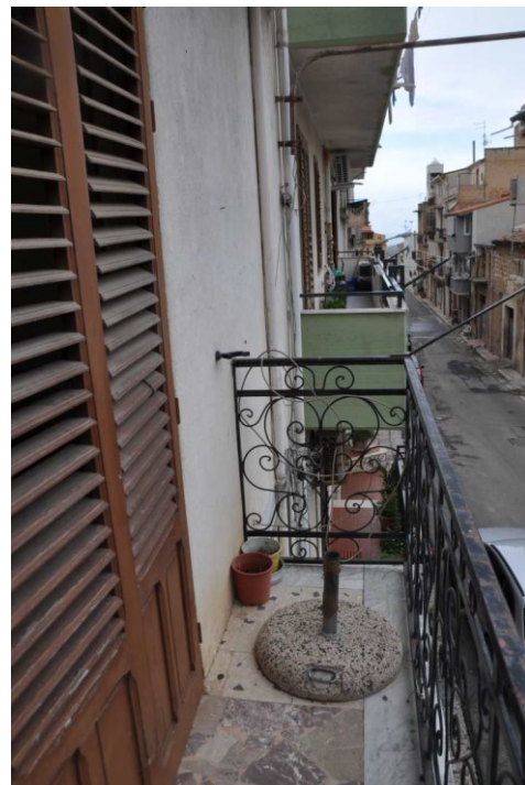
Foto 12 – Vista dal balcone di 1° piano
