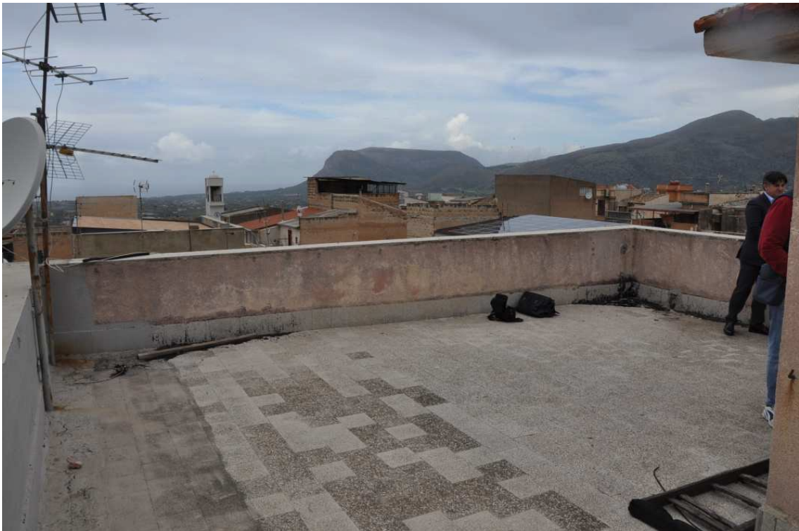
Foto 34 – 4° piano – Terrazzo scoperto (lastrico solare dell'edificio)
