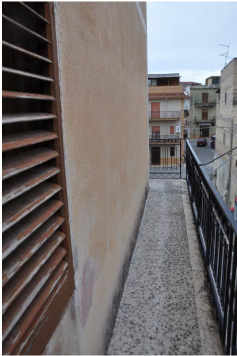
Foto 20 – Balcone su via Montegrappa
