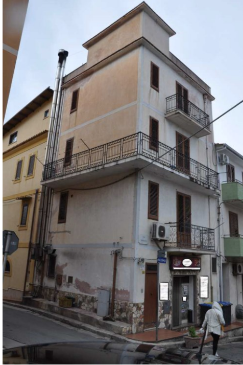
Foto 1 – L’unità edilizia – Prospetti su via Ferrara e via Montegrappa
