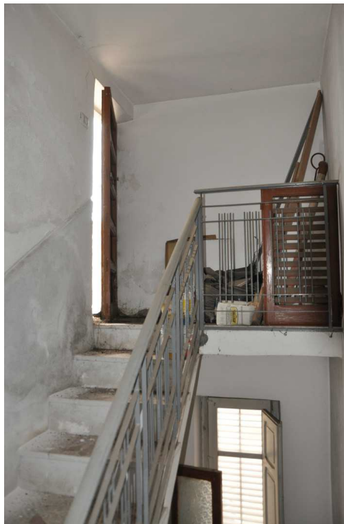
Foto 30 – Pianerottolo di 4° piano - Porta d'Ingresso alla terrazza
