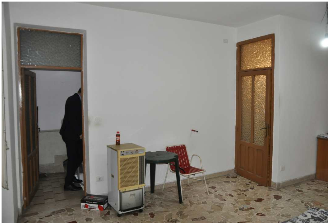
Foto 15 – Interno unità immobiliare di 2° piano – Ingressi dal corpo scala e al servizio igienico
