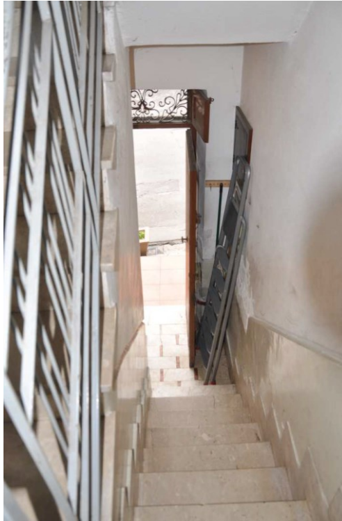
Foto 3 - Corpo scala e Ingresso all'immobile dalla via Ferrara n. 2
