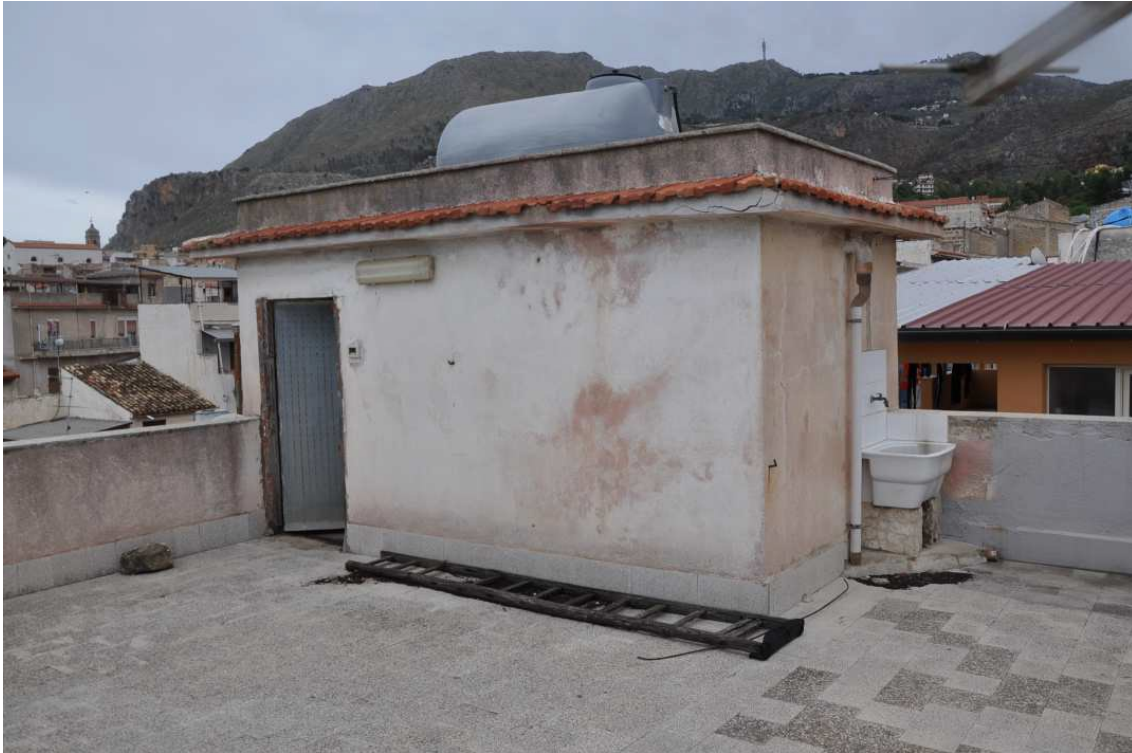
Foto 31 – Ingresso alla terrazza dal corpo scala comune
