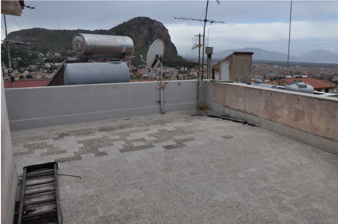
Foto 33 – 4° piano – Terrazzo scoperto (lastrico solare dell'edificio)
