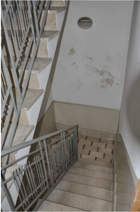
Foto 13 – Corpo scala, rampa tra P.1° e P.2°
