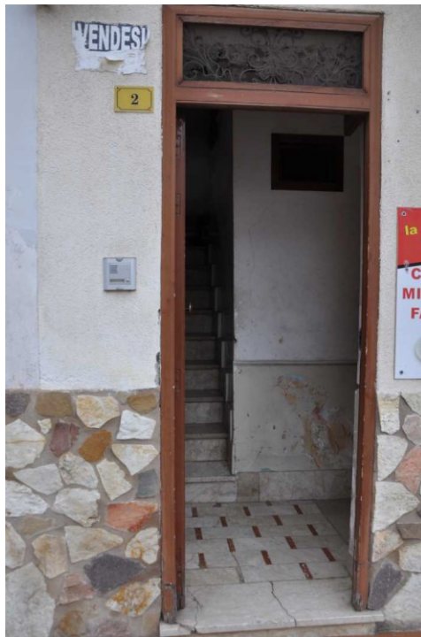
Foto 2 - Ingresso all’immobile dalla via Ferrara n. 2
