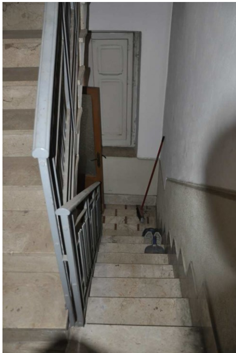
Foto 22 – Corpo scala, rampa tra P.2° e P.3°
