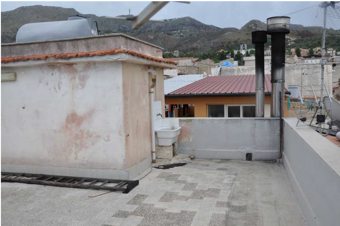
Foto 32 – 4° piano - Terrazzo scoperto (lastrico solare dell'edificio)
