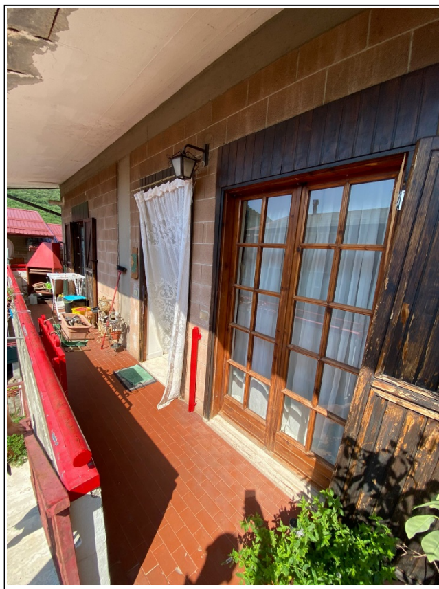
Unità abitativa con pertinenza, site nella zona periferica del Comune di Monteforte Irpino (AV), censite presso il N.C.E.U. al Foglio 13 particella 173 sub 5 e 2.
