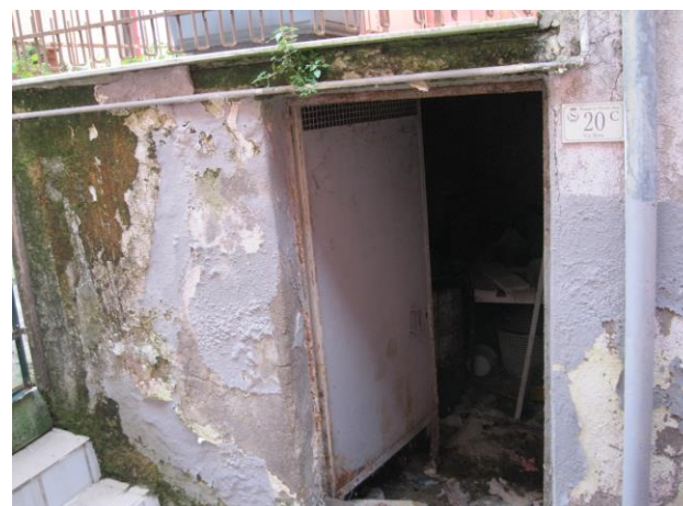
Foto 8 - Accesso ai locali cantina
