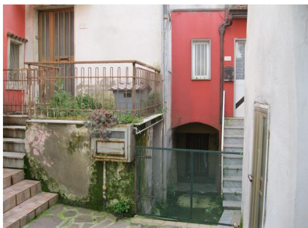
Foto 7 - Accesso al piano seminterrato
