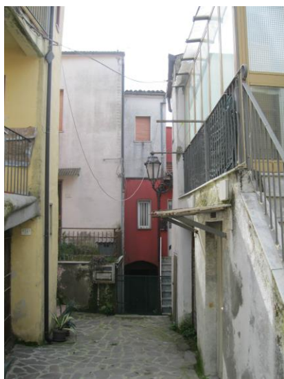
Foto 1 - Vista immobile dal vicolo
