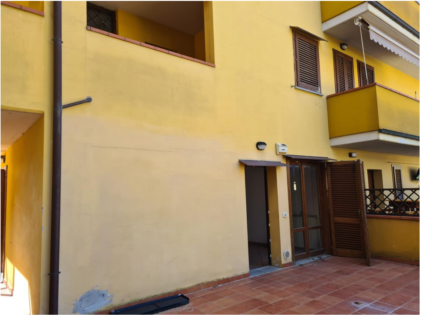
Foto 4-Porta d'ingresso vista dal terrazzo
