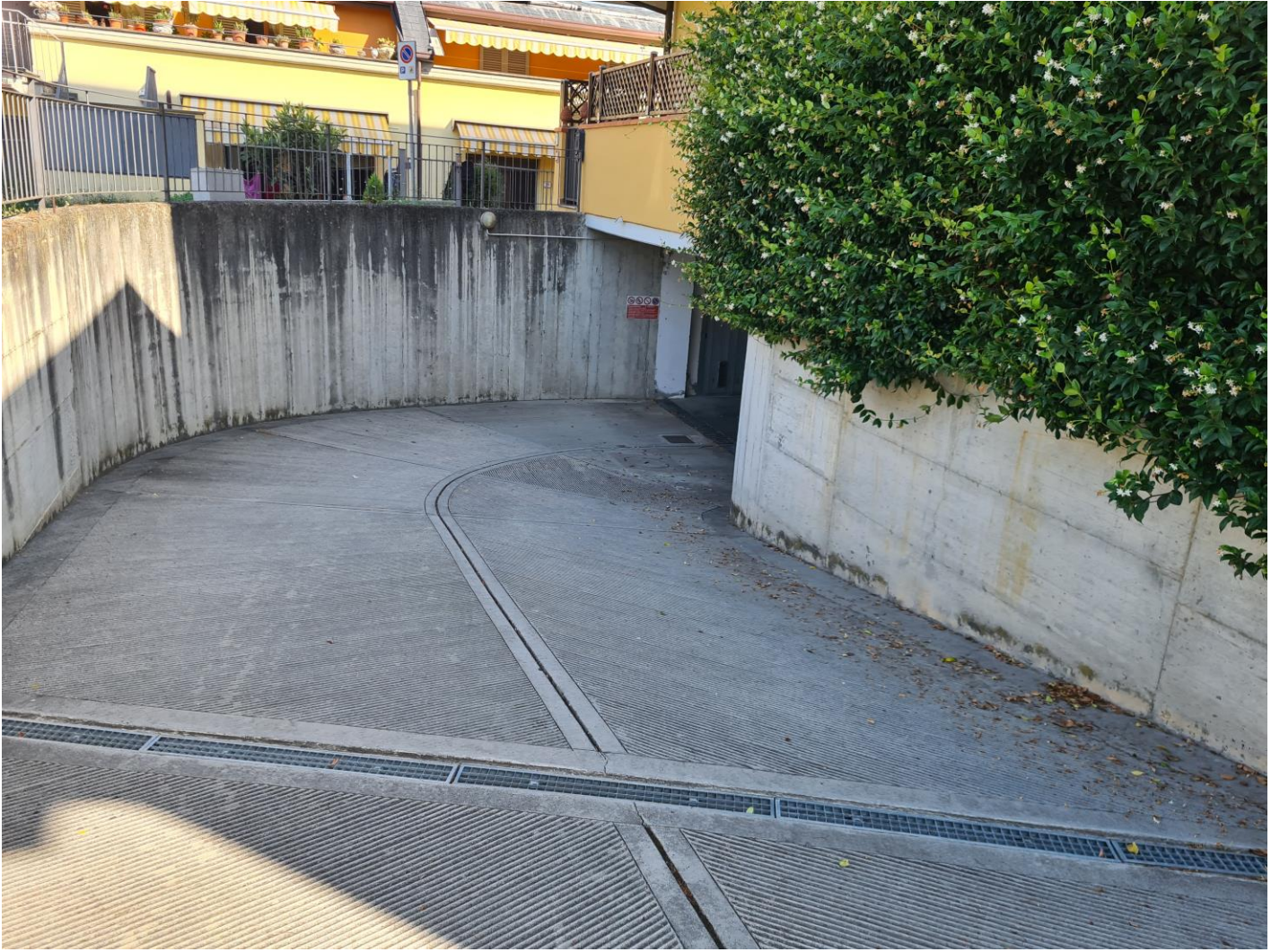
Foto 15 – Rampa di accesso ai garages
