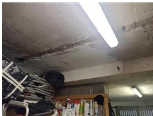
(sub. 25) la traccia del tramezzo rimosso in tempi relativamente recenti, sul soffitto al PS1
