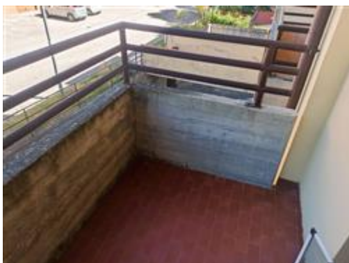
Uno dei tre balconi, con parapetto in cemento e tubolari, e tipica piastrella da esterni "da capitolato"
