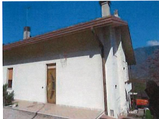
Vista ingresso sub.4 lato nord
