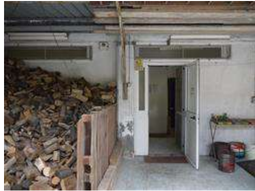
Vano di accesso ai locali
