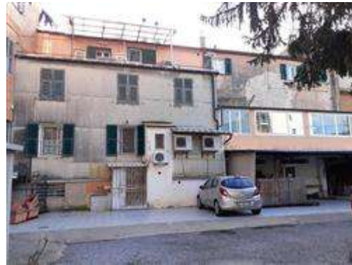
Vista retro dalla corte interna mappale 479
