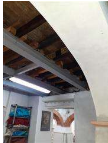
Locale magazzino - viste rinforzi strutturali
