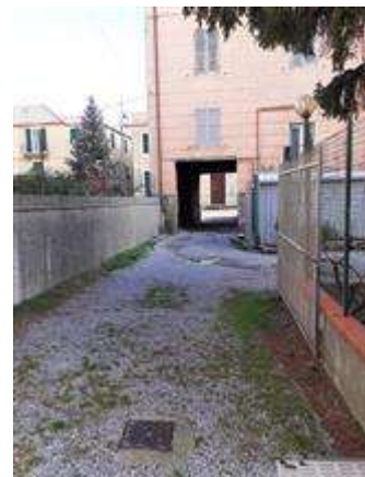
Porzioni di corte mappali 765, 766 e 767 viste percorso di accesso al magazzino corpo B
