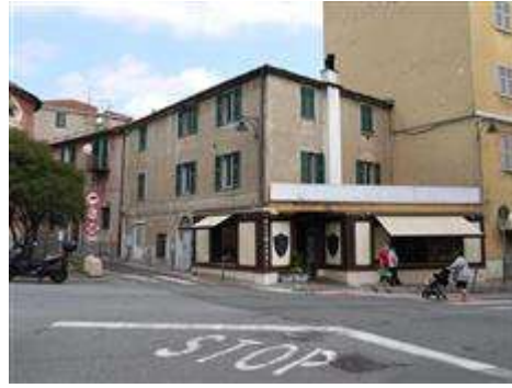
Vista fronte principale su via Bellotto e Piazza della Chiesa
