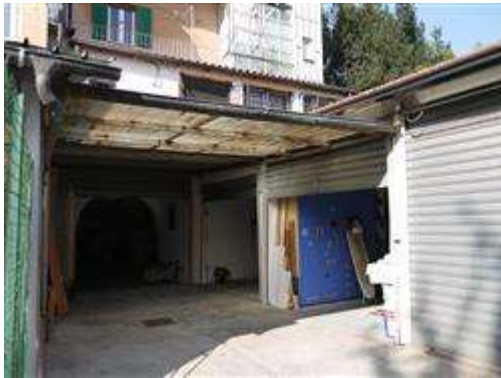
Box singolo vista percorso di accesso con area di manovra
