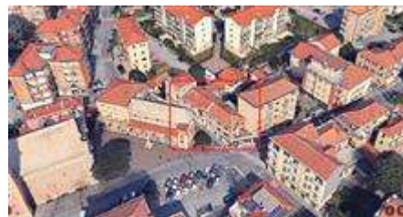
FABBRICATO VIA SAN PIETRO/VIA CIRANO BELLOTTO VISTA GENERALE
