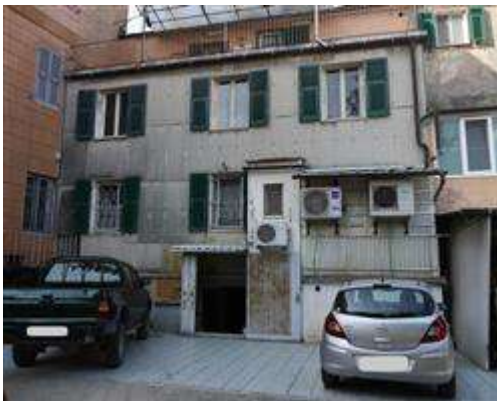
Locale magazzino - vista ingresso da corte esterna
