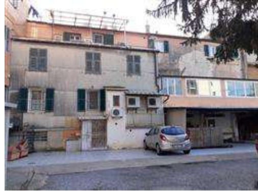
Vista retro dalla corte interna mappale 479
