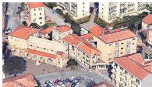
Fabbricato di civile abitazione via San Pietro/Via Bellotto vista generale fronti principali
