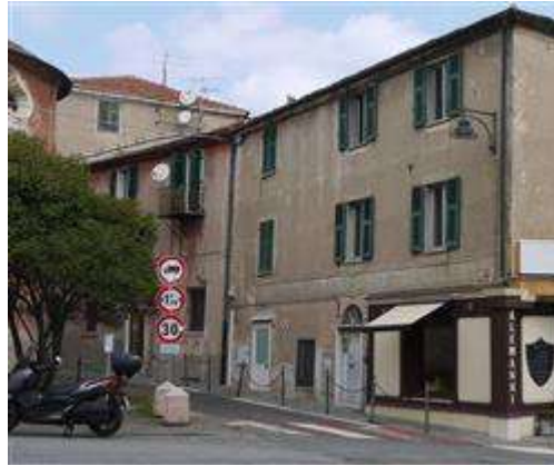
Vista fronte su via Bellotto - in primo piano il portone condominiale civ. 2 e l'ingresso al locale civ. 4
