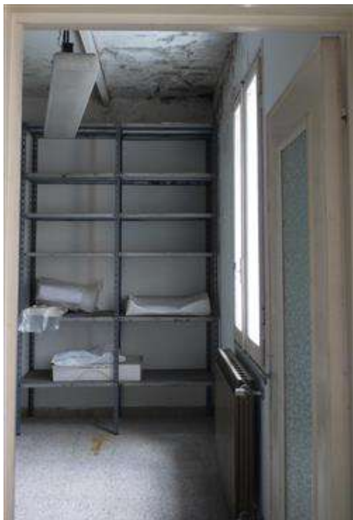
Ambienti affacciati sulla corte interna
