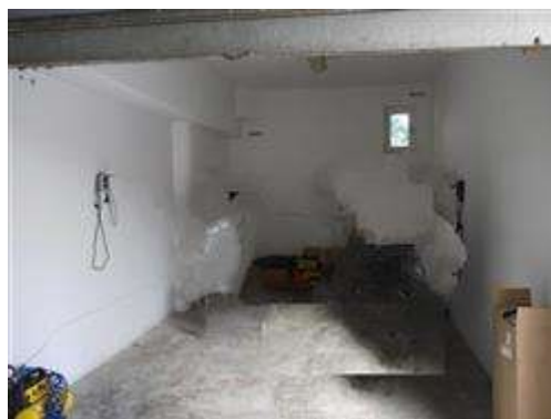
Box singolo - vista interna
