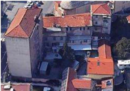
Fabbricato di civile abitazione via San Pietro/Via Bellotto vista generale lato corte interna
