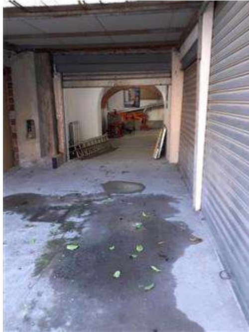
Porzione di corte di accesso ai box
