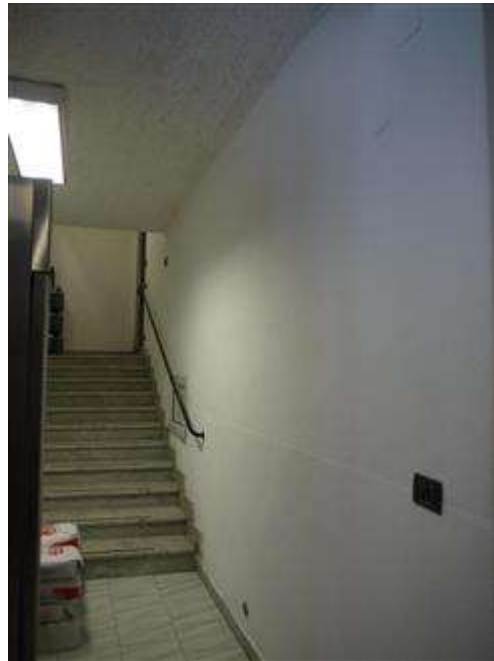
locale ingresso disimpegno e scala di collegamento al piano terreno
