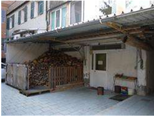
Accesso dalla porzione di corte coperta pertinenza del lotto 1
