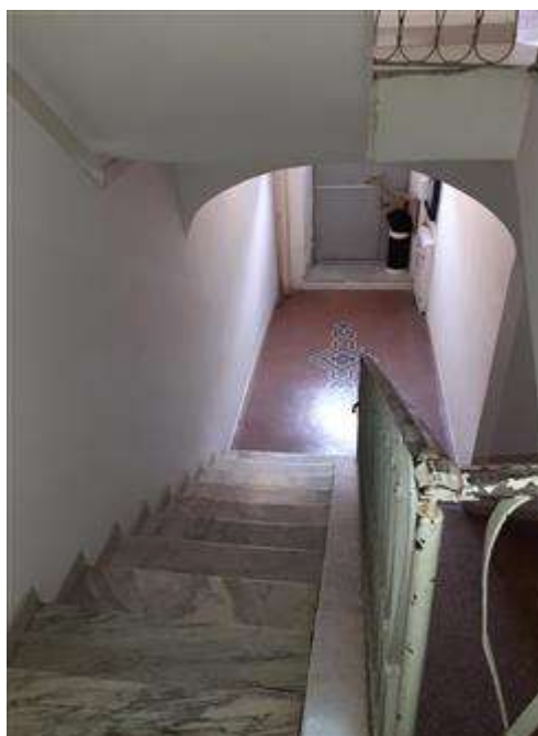
Vista vano scala comune
