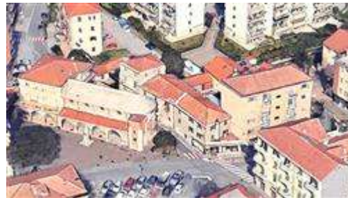
Fabbricato di civile abitazione via San Pietro/Via Bellotto vista generale fronti principali
