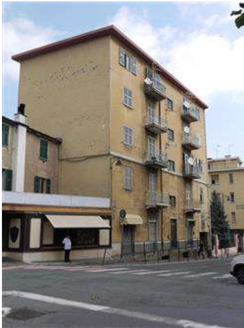
Vista fronte su via San Pietro
