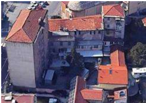
Fabbricato di civile abitazione via San Pietro/Via Bellotto vista generale lato corte interna
