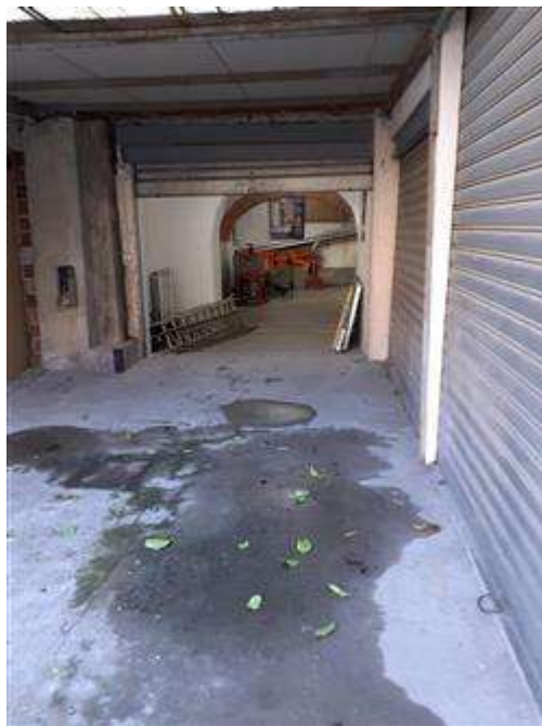
Porzione di corte di accesso ai box
