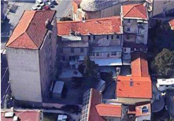
Fabbricato di civile abitazione via San Pietro/Via Bellotto vista generale lato corte interna
