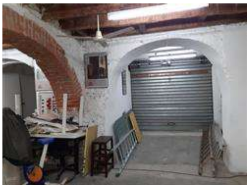
Locale magazzino corpo B - vista varco di ingresso
