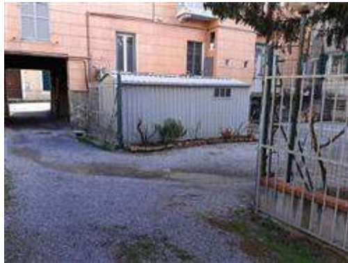
Baracca metallica adibita ad autorimessa
