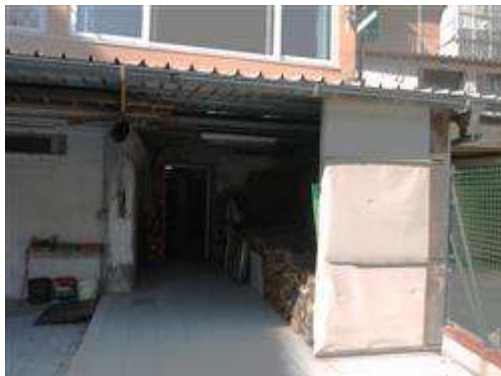
Vista ingresso al locale
