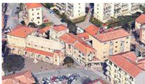
Fabbricato di civile abitazione via San Pietro/Via Bellotto vista generale fronti principali
