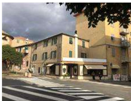
Vista fronte principale su via Bellotto e Piazza della Chiesa
