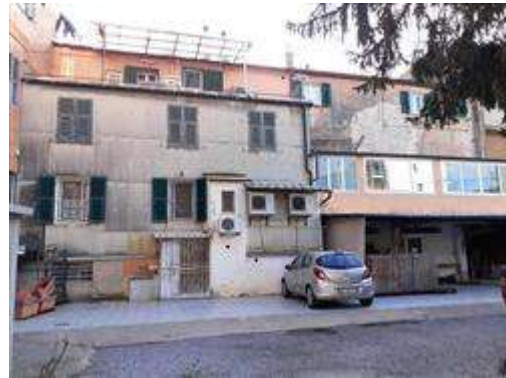
Vista retro dalla corte interna mappale 479
