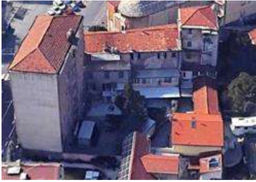
Fabbricato di civile abitazione via San Pietro/Via Bellotto vista generale lato corte interna
