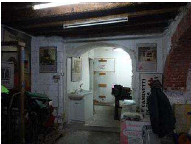
Locale magazzino corpo B - vista locale di sgombero
