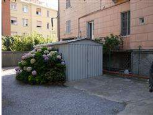
Baracca in lamiera prefabbricata - vista generale
