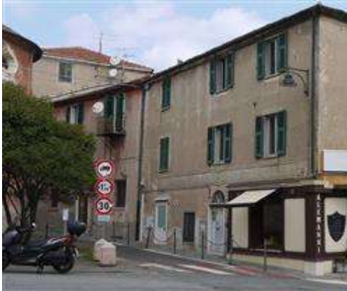
Vista portone di ingresso via Belotto civ. 2
