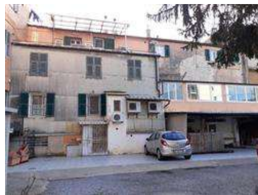
Vista retro dalla corte interna mappale 479
