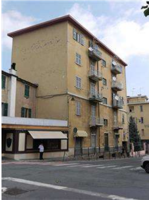
Vista fronte su via San Pietro
