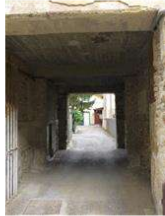
Varco di accesso alla corte da via San Pietro
