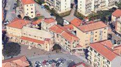
Fabbricato di civile abitazione via San Pietro/Via Bellotto vista generale fronti principali
