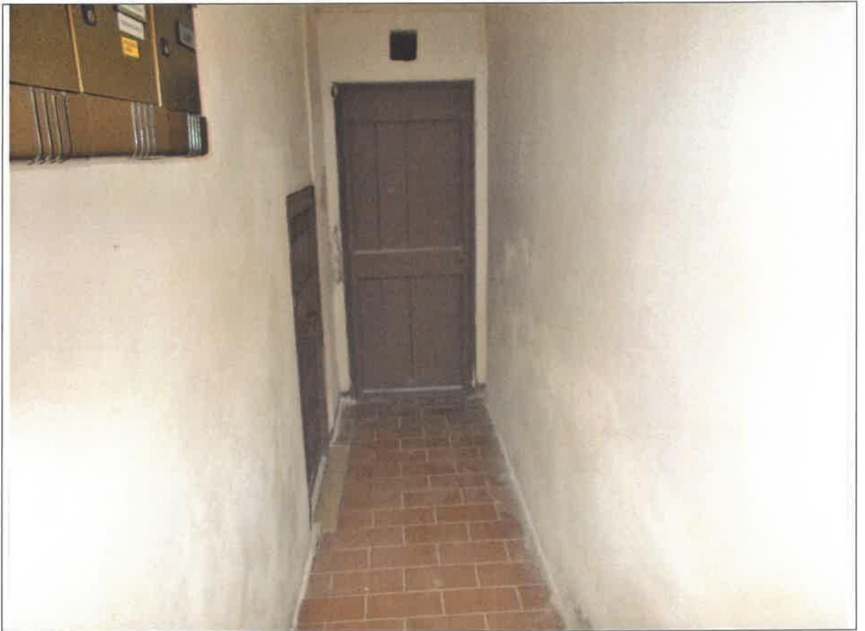
RIPOSTIGLIO PIANO TERRA
