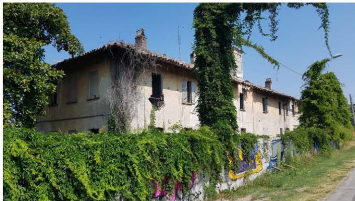
VISTA FACCIATA LATO SUD DA VIA ALZAIA
