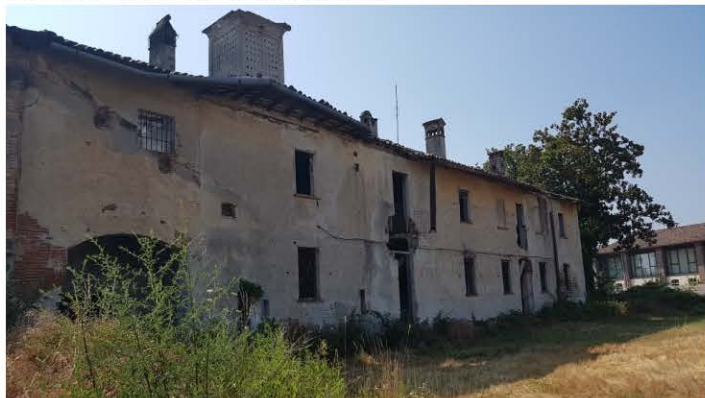
VISTA FACCIATA LATO OVEST
