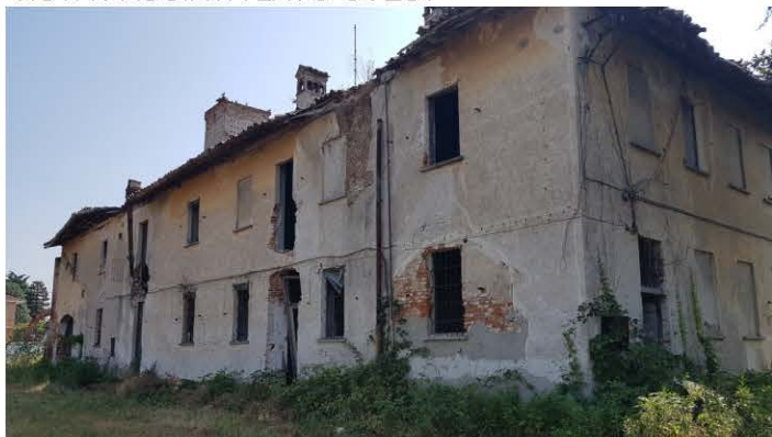
VISTA FACCIATA LATO OVEST
