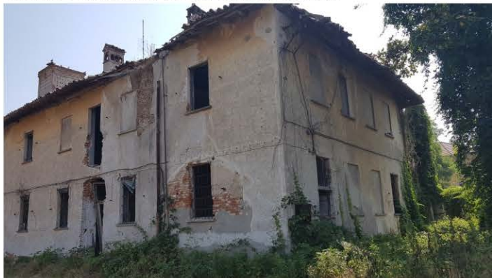
VISTA FACCIATA LATO OVEST E SUD
