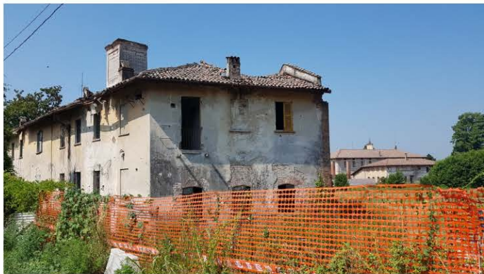
VISTA FACCIATA LATO NORD DA VIA ALZAIA
