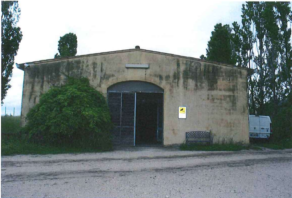
FOTO N° 1 Vista esterna - lato Sud-Est – ingresso principale
