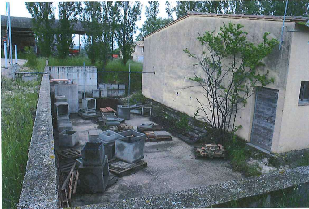
FOTO N° 3 Vista esterna lato Nord-Ovest – sito ove erano collocati i silos
