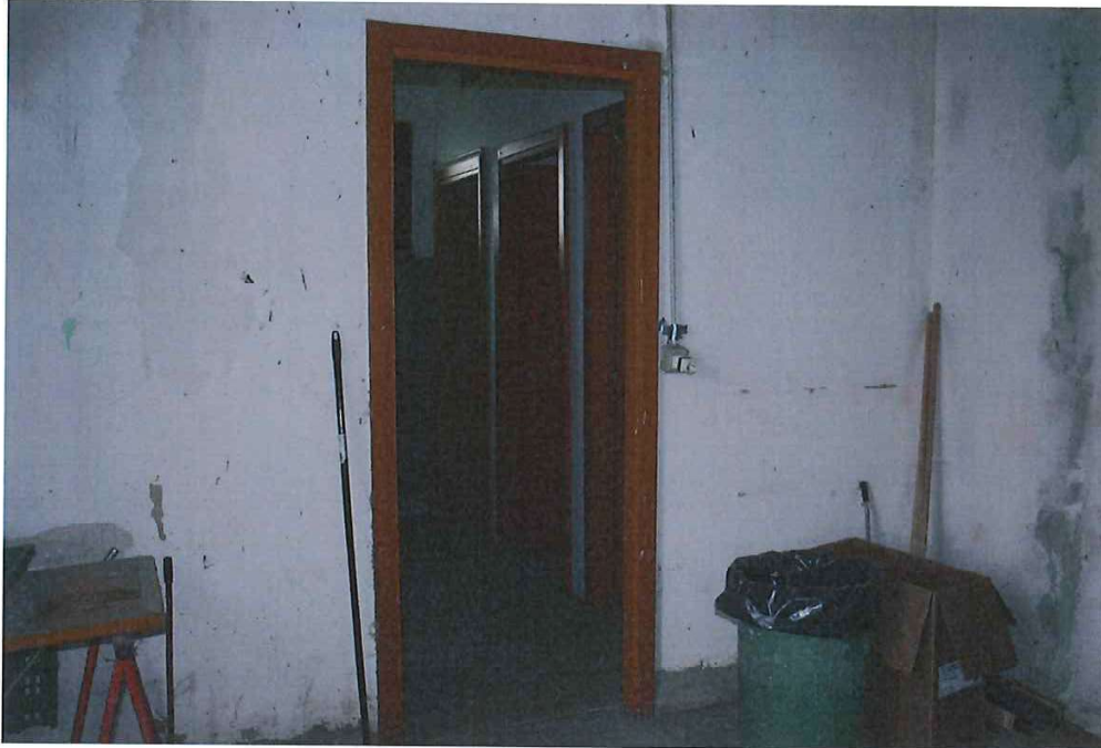
Vista interna – ingresso servizi
