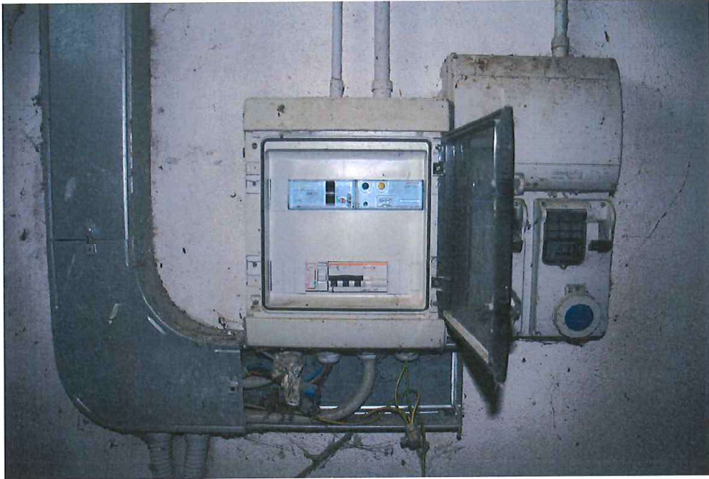
FOTO N° 10 Centralino Elettrico
