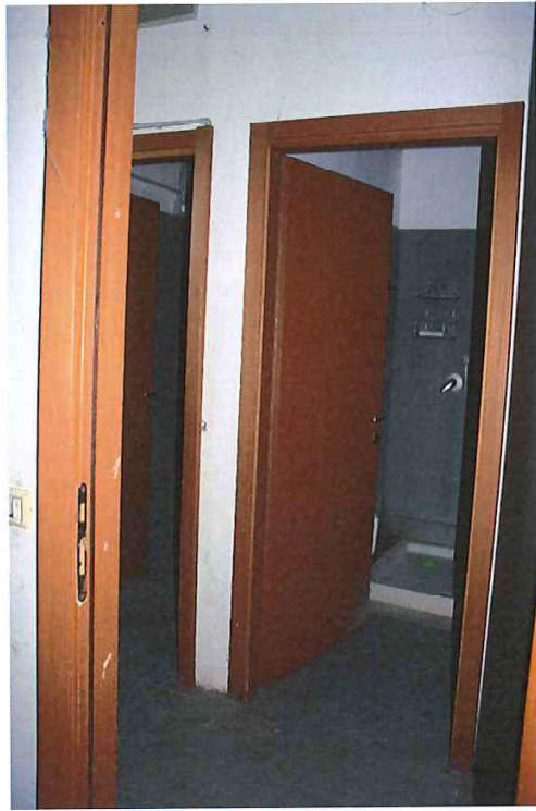
FOTO N° 7 Foto interna – servizi
