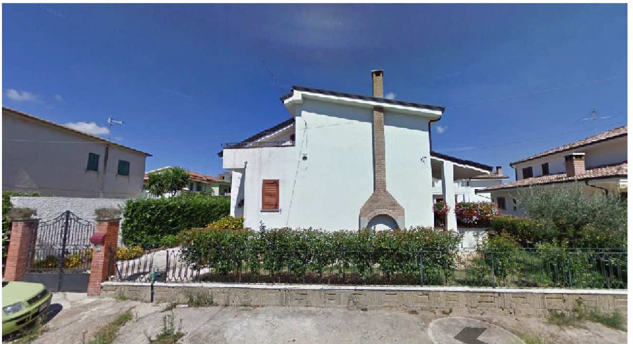
Foto n. 3 di 48 ( Vista frontale da via Grella)
