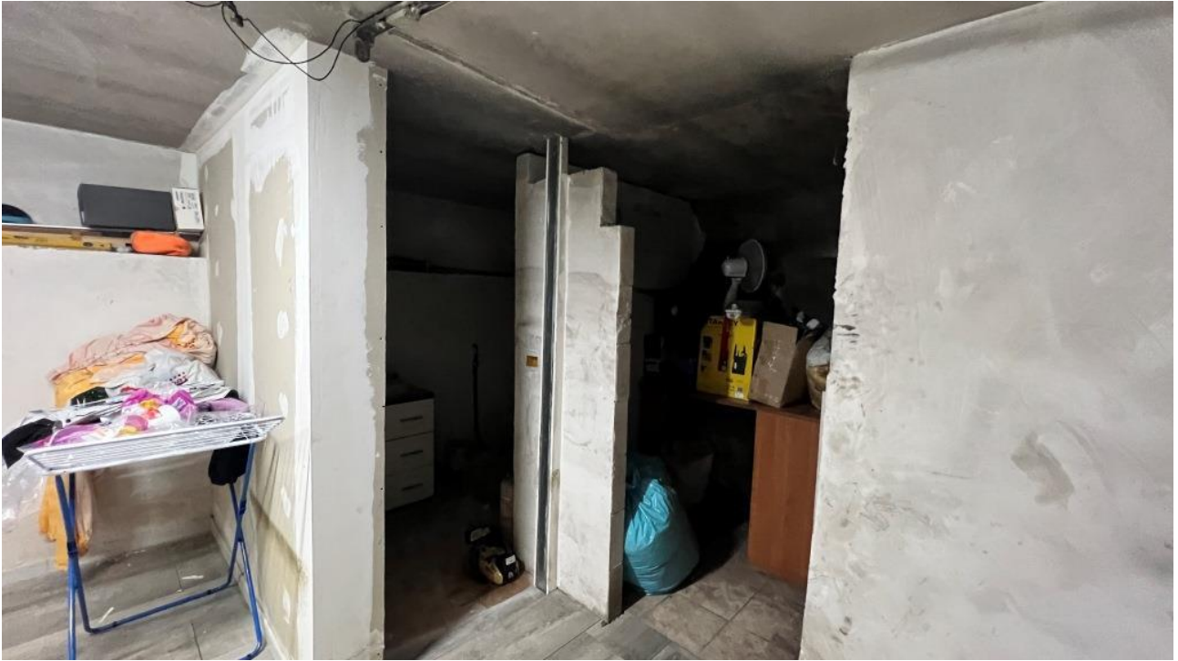
Foto 21 – Tramezzi di divisione nel secondo vano del piano interrato
