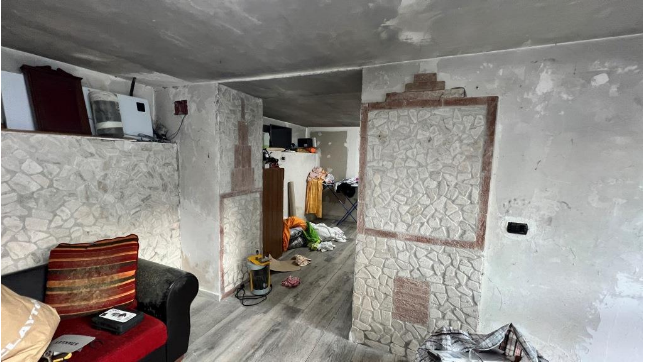
Foto 19 – Apertura interna nel vano d'ingresso per accesso ad altro vano
