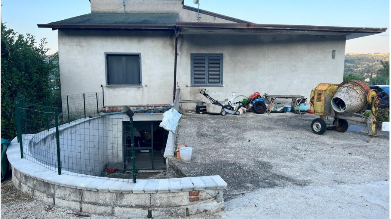
Foto 15 – Vista posteriore dell'abitazione lato OVEST
