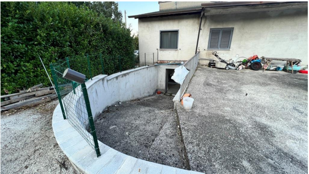
Foto 16 – Rampa di accesso al piano interrato
