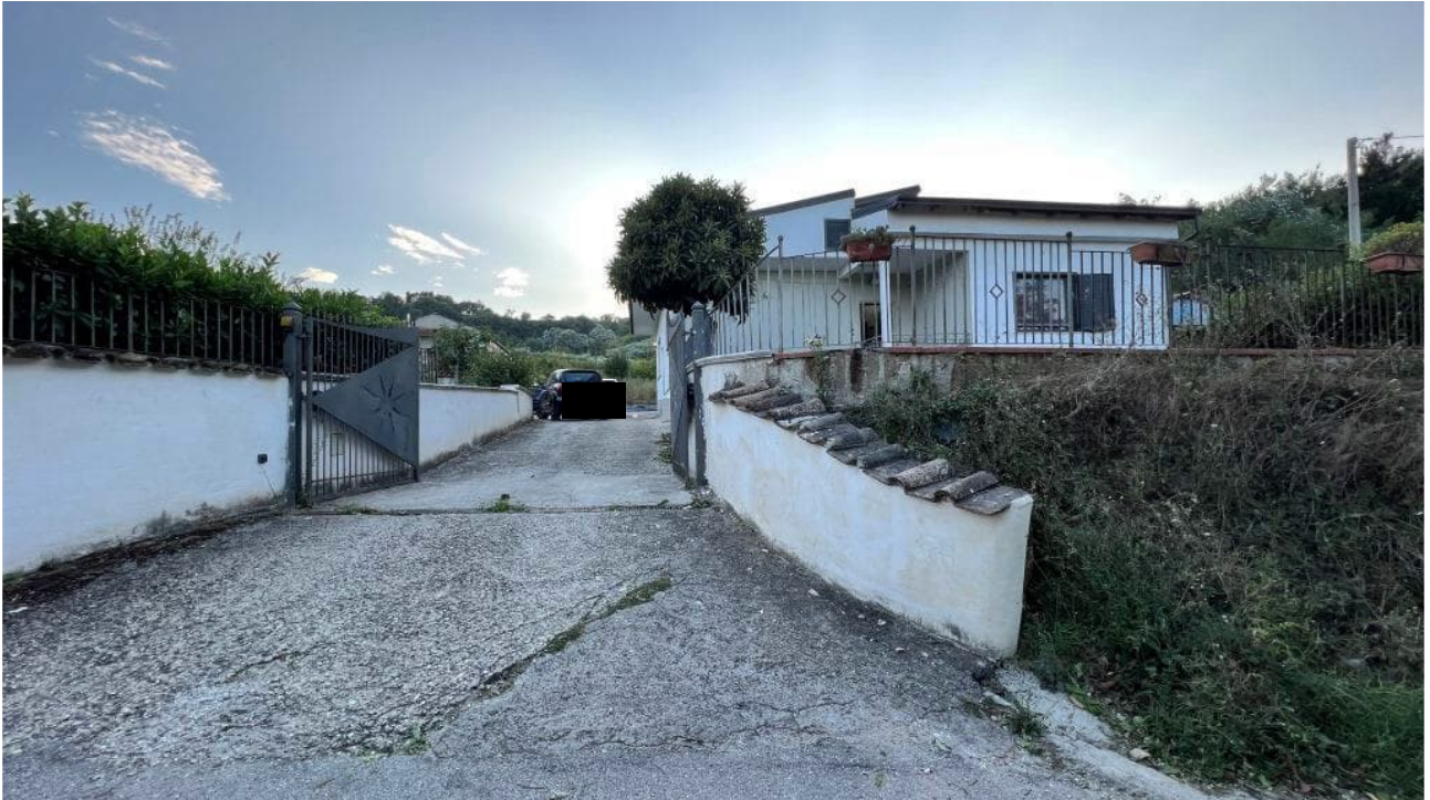
Foto 1 – Accesso all'immobile dalla via Pozzetiello
