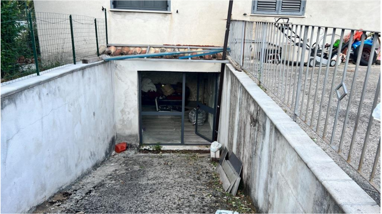
Foto 17 – Ingresso al piano interrato
