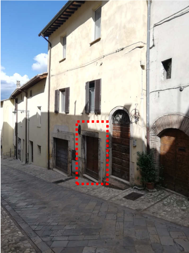
1) Prospetto lato via Leone IV
