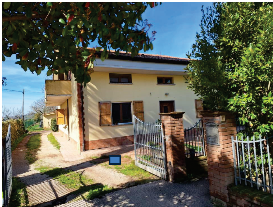
FOTO 1 – Prima vista dall'esterno del fabbricato.
