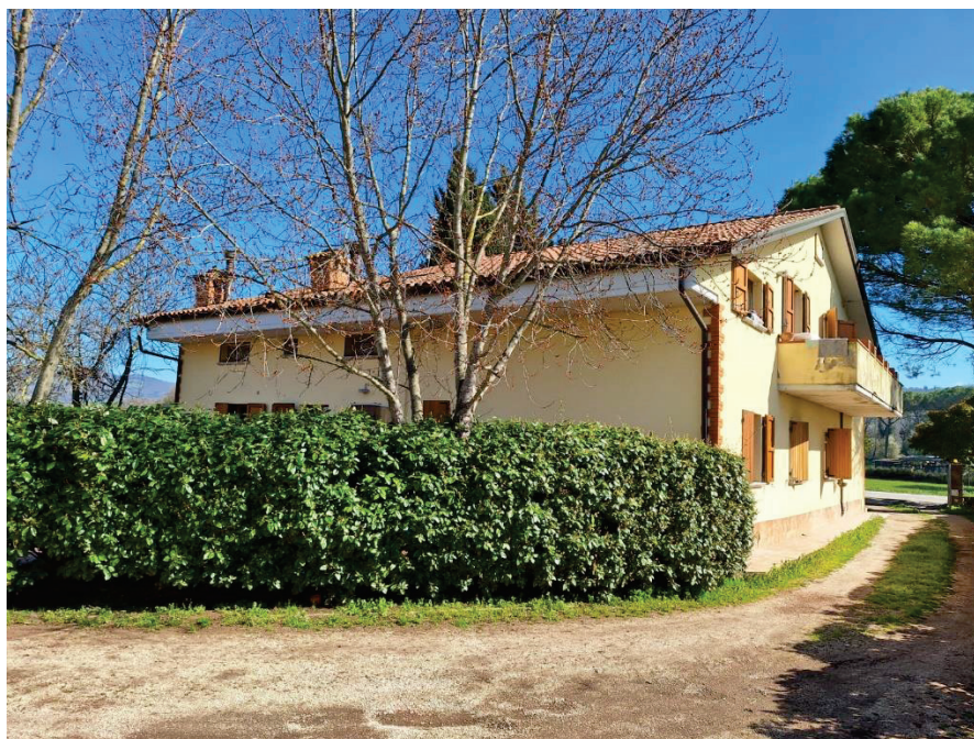
FOTO 2 – Seconda vista dall'esterno del fabbricato.
