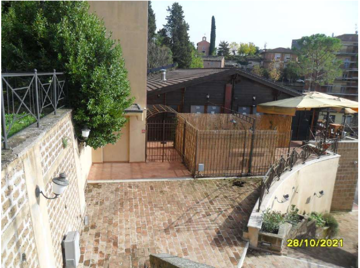
esterno fabbricato - lato ovest (accesso superiore dalla strada dell' Ortera)
