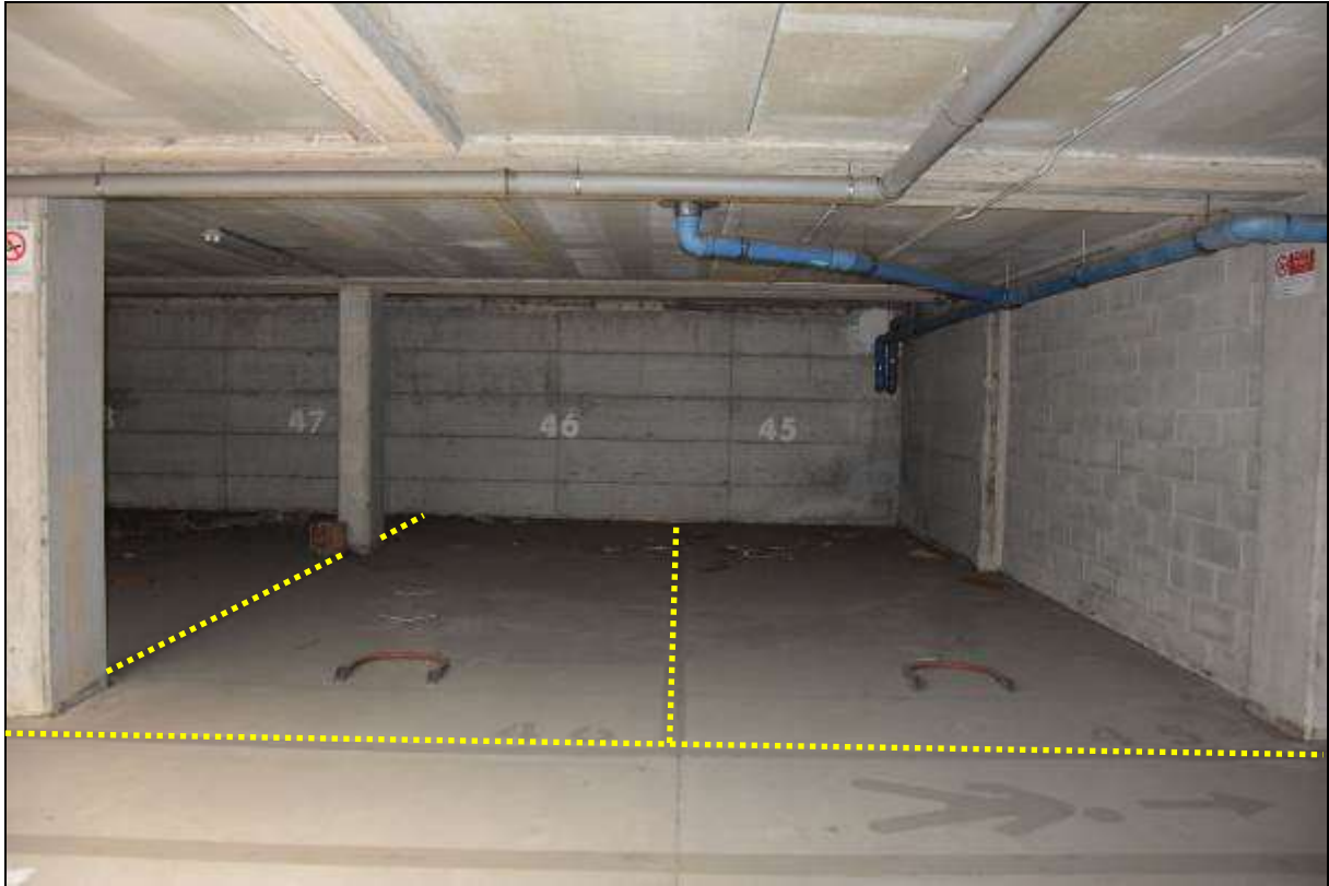
FOTO 1 – SUB 104 (POSTO 46) / SUB 105 (POSTO 45)
