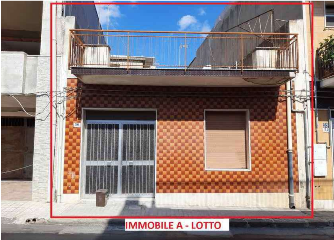
G.01 – Esterno lato Est - edificio corrispondente all'Immobile A.
