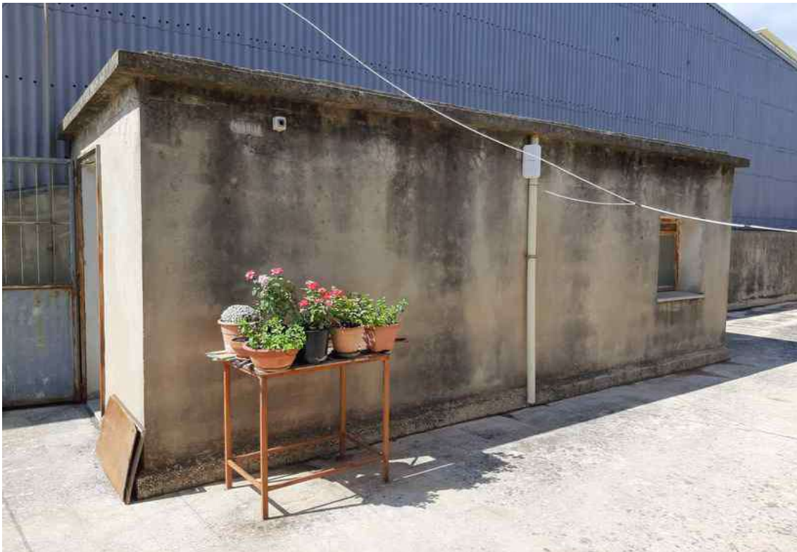
G.29 – Esterno del vano scala per l'uscita sul terrazzo.
