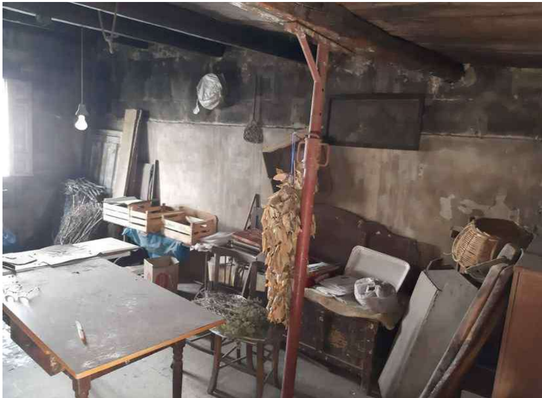
G.36 – altra veduta del locale forno.
