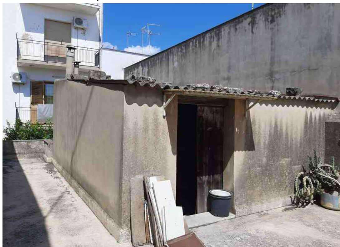
G.33 – Veduta del Terrazzo lato Ovest – altra veduta del locale forno.
