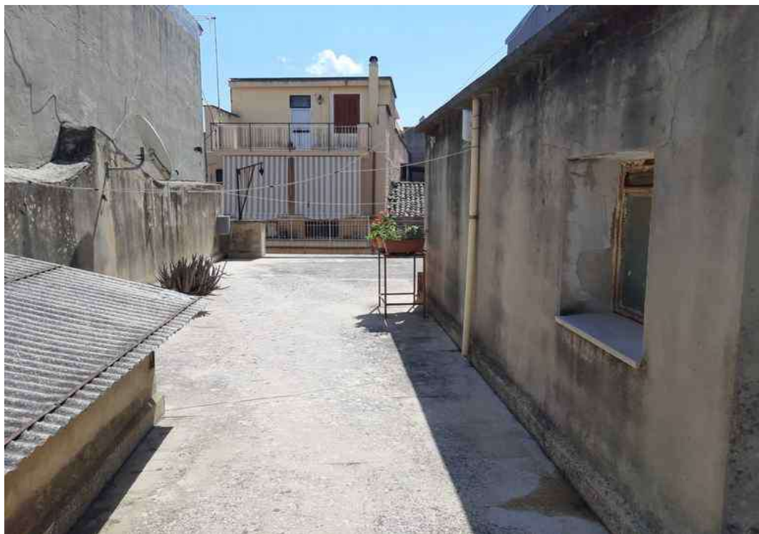
G.30 – Veduta del Terrazzo lato Est.
