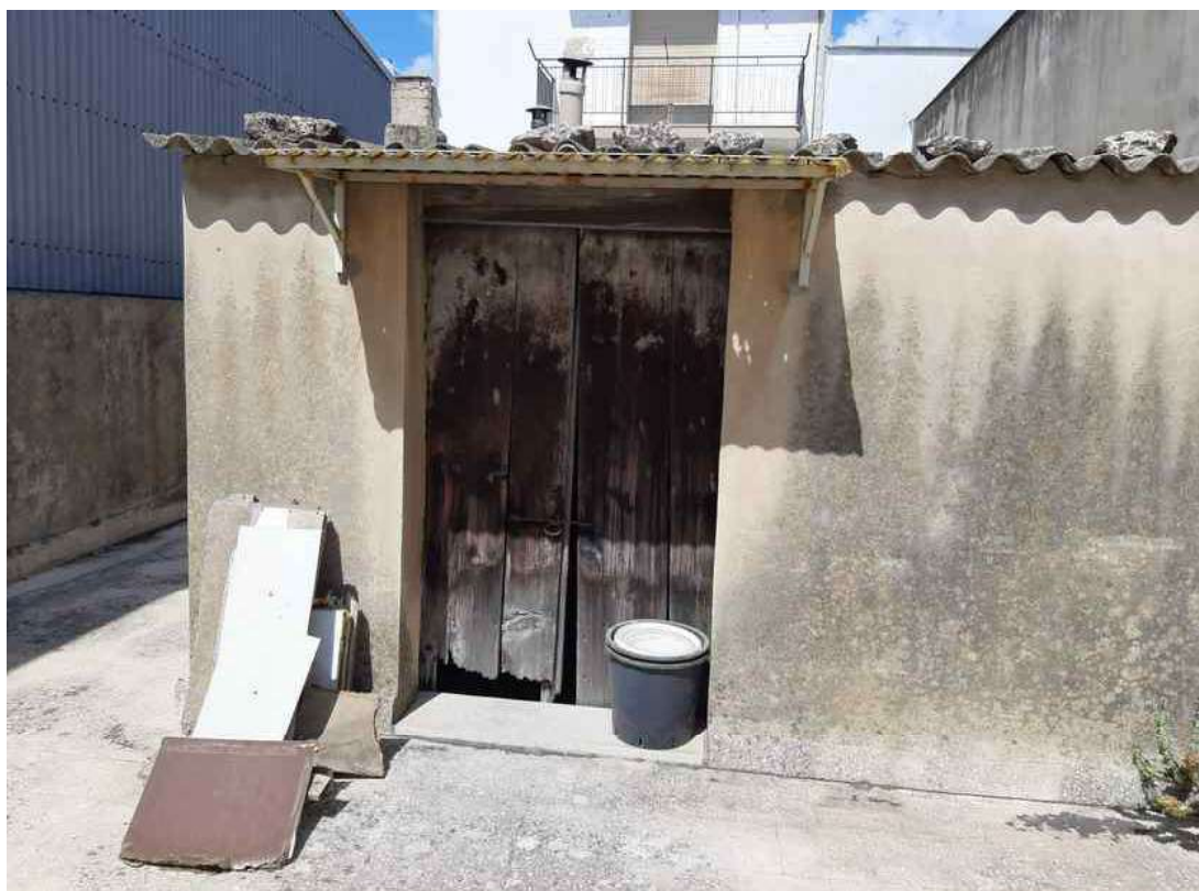
G.32 – Veduta della porta di accesso al locale forno.
