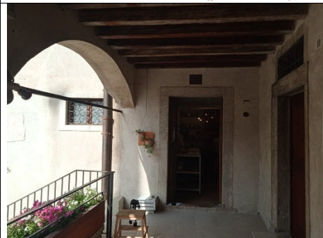
Foto 6. VISTA ESTERNA (ingresso com.)
