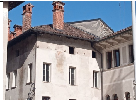
Foto 4. VISTA ESTERNA (particolare)
