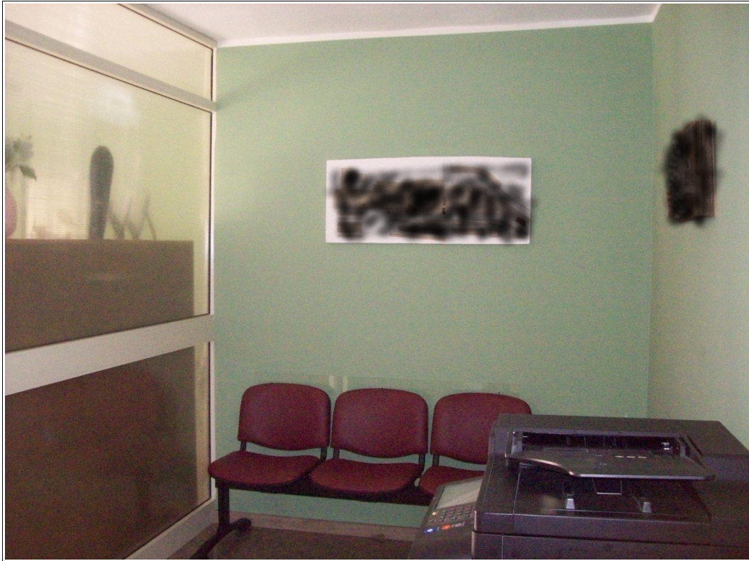
Foto n. 10: Interno | dettaglio della parete/infisso in alluminio e vetro che funge da divisorio interno
