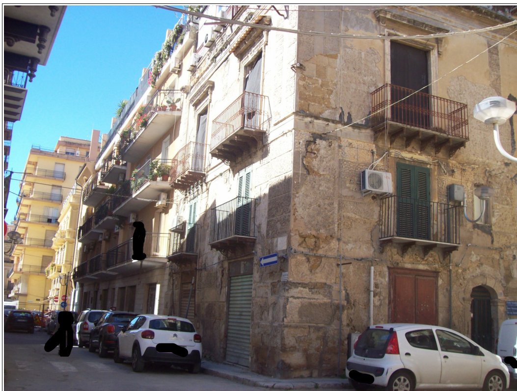
Foto n. 1: Esterno | prospetti est e nord del fabbricato di cui è parte l'unità immobiliare
