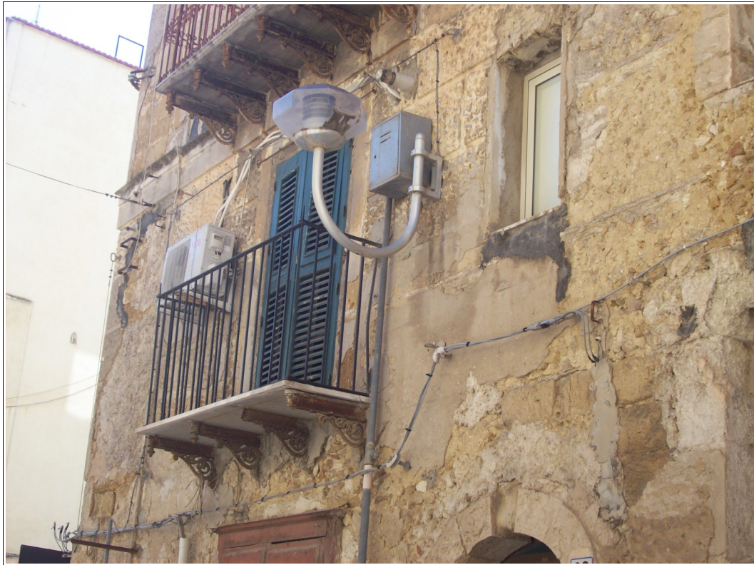
Foto n. 3: Esterno | via Ventura | dettaglio del prospetto nord all'altezza del primo piano
