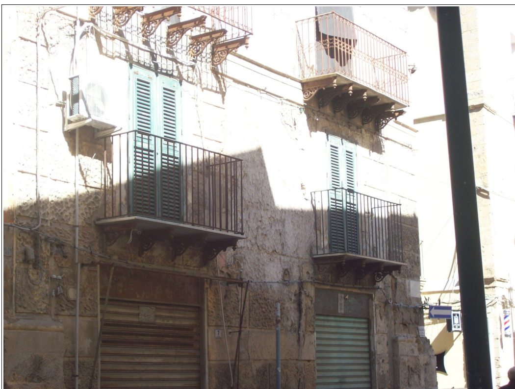
Foto n. 6: Esterno | via Aretusa | dettaglio del prospetto est all'altezza del primo piano
