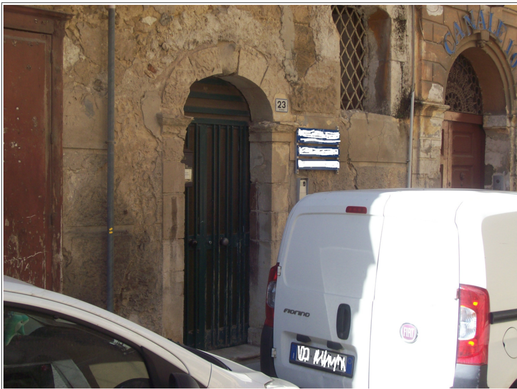
Foto n. 4 : Esterno | via Ventura | dettaglio del prospetto nord all'altezza del pianoterra | ingresso dell'unità immobiliare
