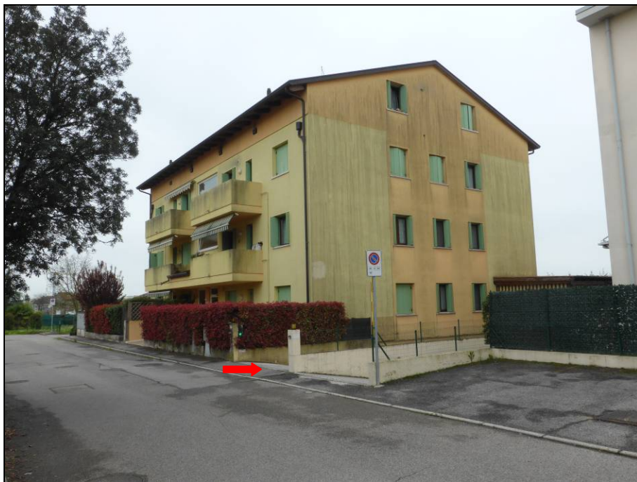
Foto n. 1 – Condominio “Gelsomino” con indicazione dell’accesso carraio (accesso ai garage del piano interrato)
