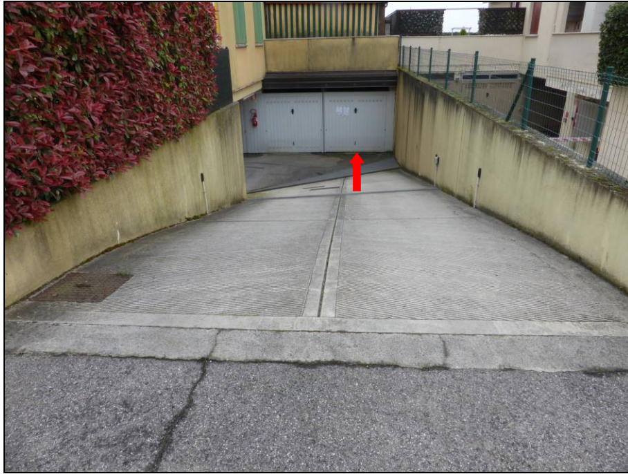
Foto n. 3 – Rampa di accesso al piano interrato con indicazione del garage eseguito (Subalterno 9)
