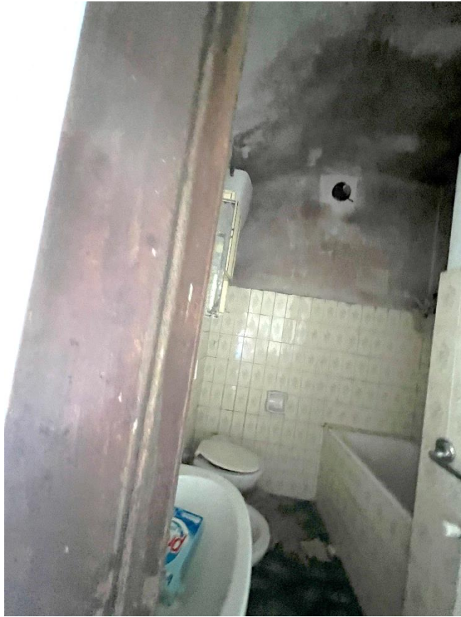
Foto 15. Bagno al secondo piano
