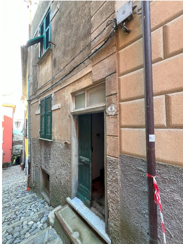
Foto 3. Ingresso su Via alla Chiesa
