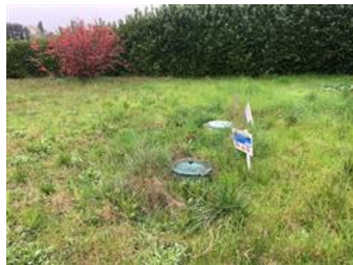
Serbatoi GPL nell'area scoperta mappale n. 319
