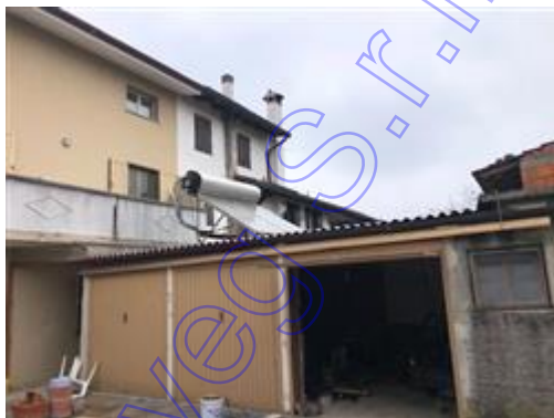
Pannelli solari sulla copertura dell'autorimessa
