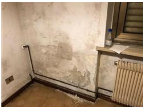
Pareti locale ripostiglio e centrale termica al piano terra
