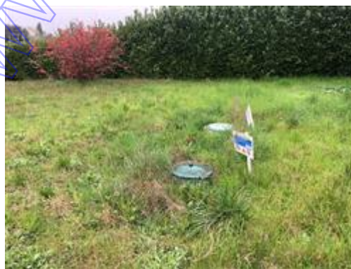
Serbatoi GPL nell'area scoperta mappale n. 319
